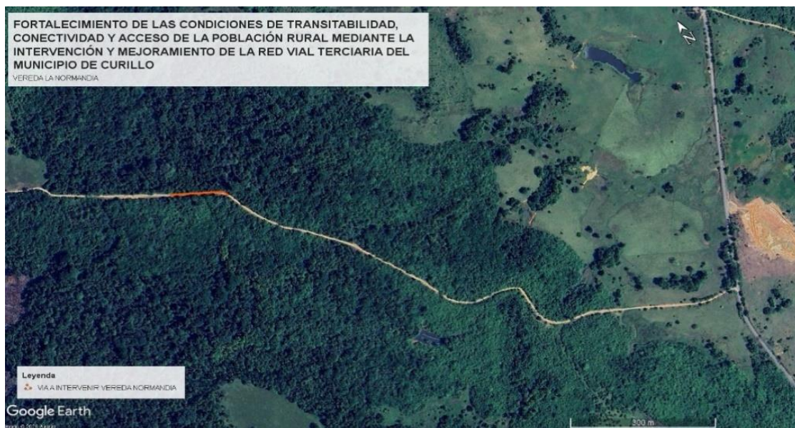
Figura 1. Vía a intervenir, vereda La Normandía, municipio de Curillo. Fuente: Anexo 1 – Anexo Técnico.
