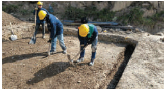
EXCAVACIÓN MANUAL EN MATERIAL COMUN
