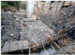
SUMINISTRO E INSTALACION DE CONCRETO CICLOPEO
