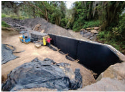
CONSTRUCCION DE FILTROS A CUALQUIER PROFUNDIDAD
