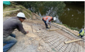
SUMINISTRO E INSTALACION DE MALLA ELECTROSOLDADA
