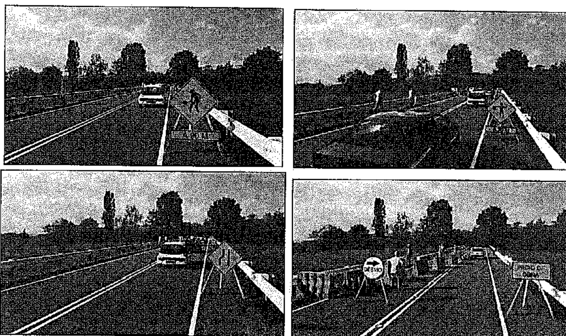
Ilustración 4. Esquema de elementos de señalización en cierre parcial. Fuente: Plan de Manejo de tránsito, Consorcio PEB JI, 2026.
