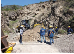
EXCAVACIÓN MANUAL EN MATERIAL COMUN
