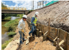
CONCRETO PARA VIGA DE AMARRE 21 Mpa
