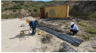
SUMINISTRO FIGURADO Y ARMADO DE ACERO
