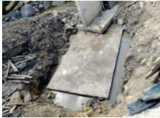
SUMINISTRO E INSTALACION DE CONCRETO CICLOPEO
