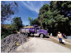
TRANSPORTE DE MATERIAL DE AFIRMADO Y/O GRANULAR SUELTO
