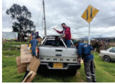
SUMINISTRO E INSTALACIÓN DE SEÑAL DE TRANSITO PREVENTIVA, REGLAMENTARIA O INFORMATIVA
