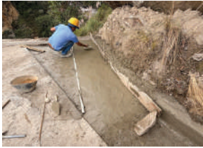
CUNETAS REVESTIDAS EN CONCRETO DE 21 MPA
