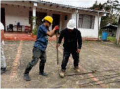
SUMINISTRO FIGURADO Y ARMADO DE ACERO
