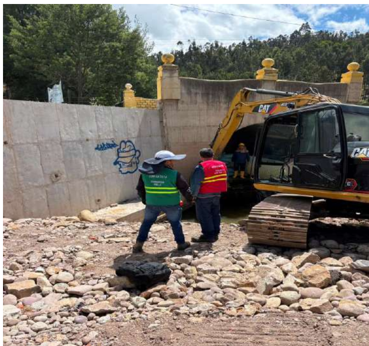
Imagen 2. ALETA DEL PUENTE - MARGEN DERECHO
