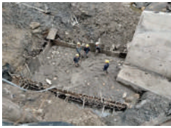
SUMINISTRO E INSTALACION DE CONCRETO CICLOPEO
