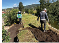
EMPRADIZACION DE TALUDES CON BLOQUES DE CESPED
