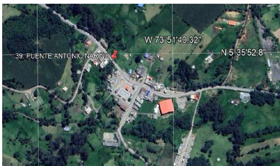
Puente Antonio Nariño, Municipio de Caldas – Provincia de Occidente
