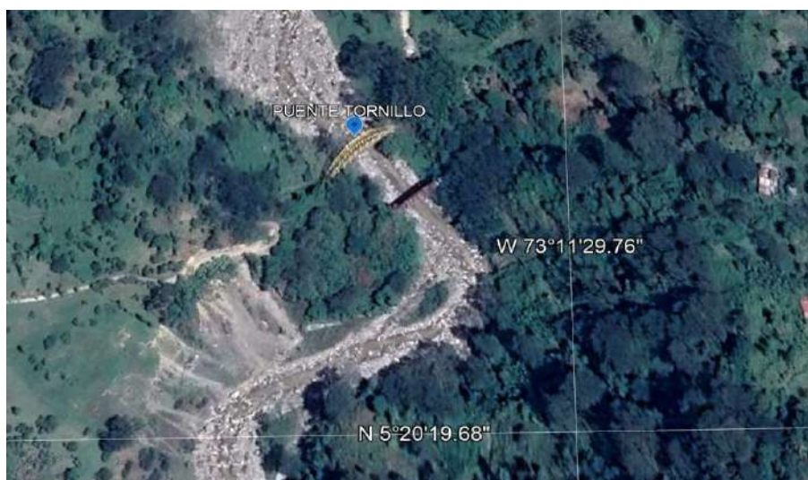
Puente Tornillo – Municipio de Rondon – Provincia de Lengupá.
