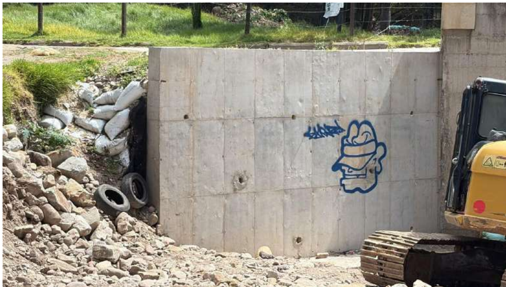
Imagen 1. ALETA DEL PUENTE - MARGEN DERECHO
