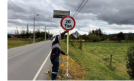
SUMINISTRO E INSTALACIÓN DE SEÑAL DE TRANSITO PREVENTIVA, REGLAMENTARIA O INFORMATIVA
