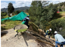
SUMINISTRO E INSTALACIÓN DE CONCRETO CICLOPEO DE 17.5 MPa
