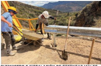
SUMINISTRO E INSTALACIÓN DE DEFENSAS VIALES TRAMO RECTO
