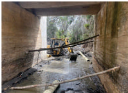
EXCAVACIONES MECANICAS VARIAS EN ROCA BAJO AGUA
