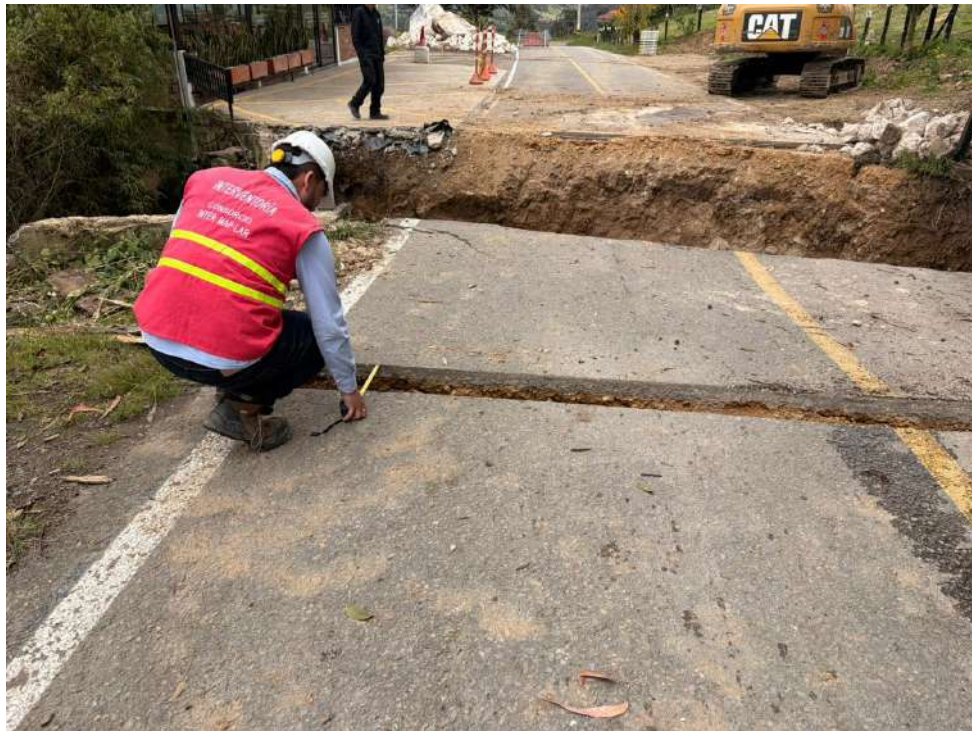
Imagen 1. INSPECCIÓN DILATACIÓN - JUEVES 25 DE JUNIO
