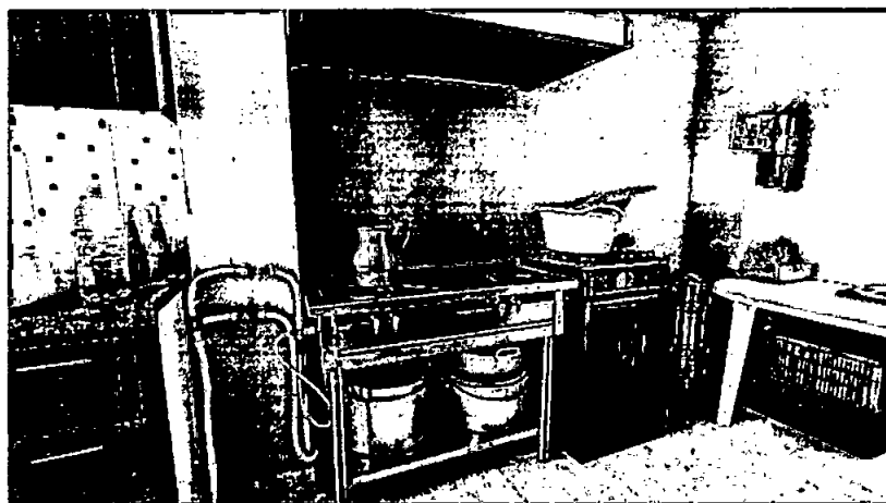
Falta de echape ceramico en paredes de la cocina, zona de estufas.
