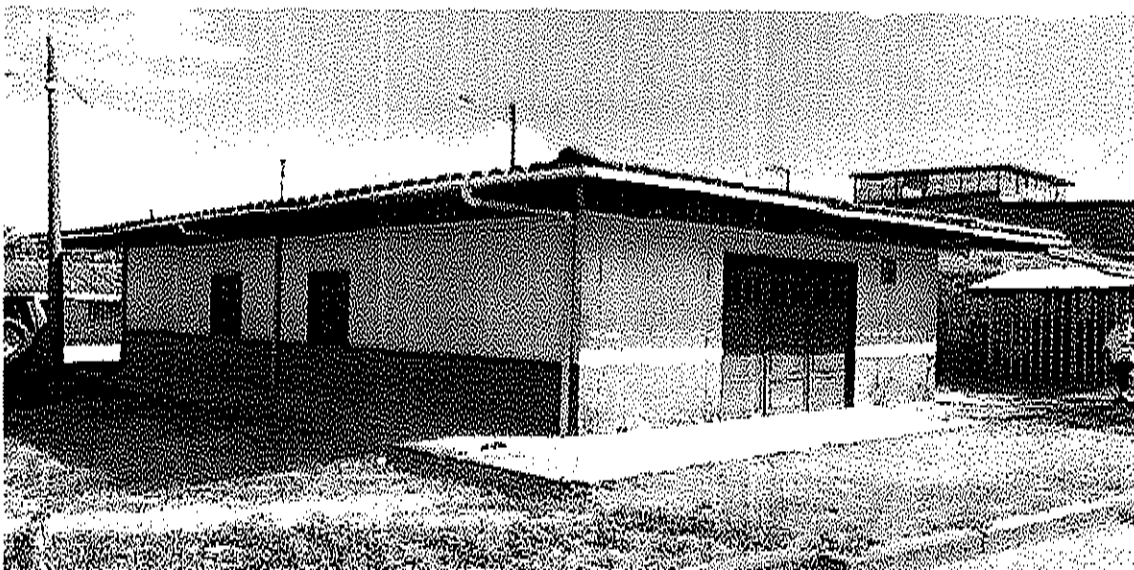
Estado existente de la caseta comunal Los Álamos. Fuente: registro fotográfico suministrado.
