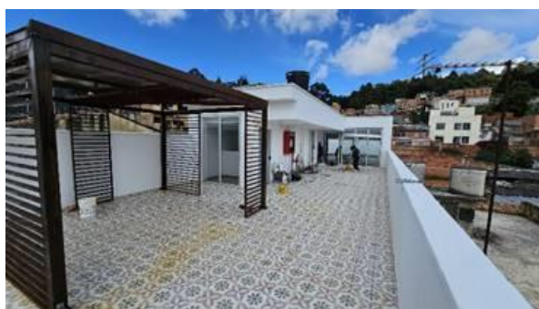
Imagen 3. Pérgola y área abierta
