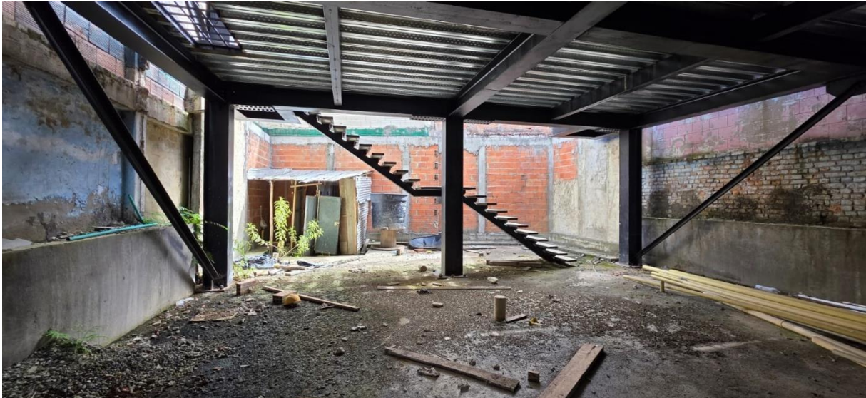
Ilustración 4 - Estado agosto 2026 Sótano
