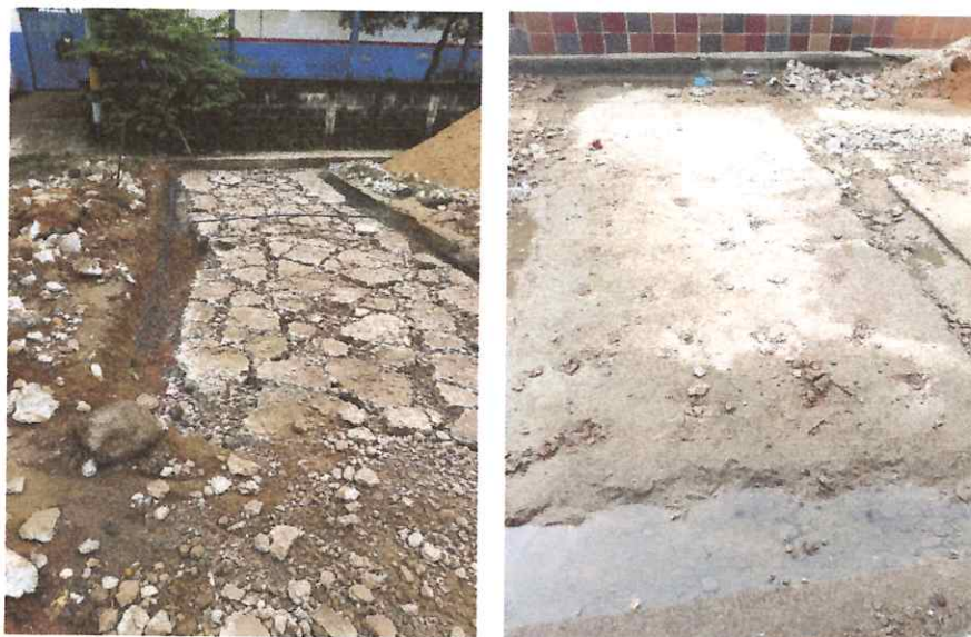
Figura 3. Demolición de concreto para la construcción de los resaltos
