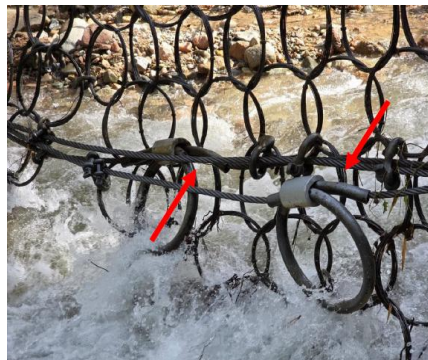
Detalle de activación de elementos del sistema de frenos
