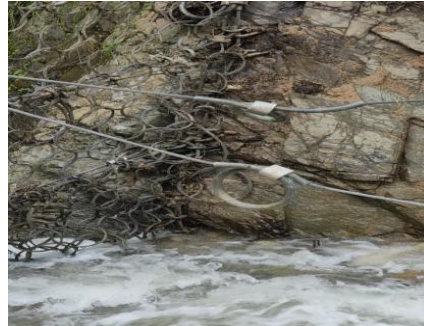
Detalle de activación de elementos del sistema de frenos
