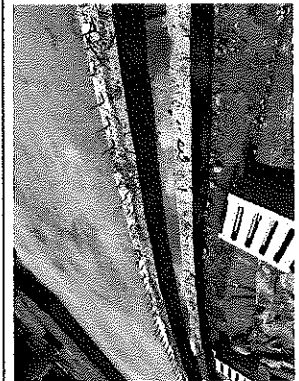
Suministro de rejilla para cárcamo interno de la pista con ancho 0,50 m. prefabricada en concreto reforzado. E= 0,06 m.
