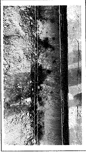
Malla electrosoldada de 0,15x0,15 mts.
