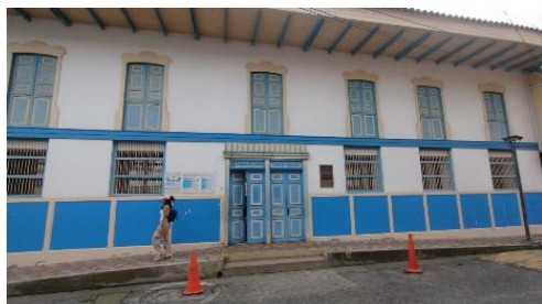
Figura 11. Fachada Oeste del edificio. Fuente: UT T&D Energy
