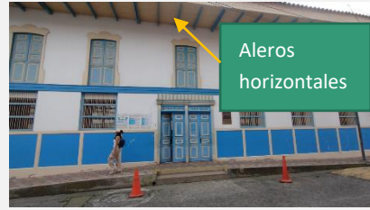
Figura 9. Protecciones exteriores. Fuente: UT T&D Energy, visita técnica
