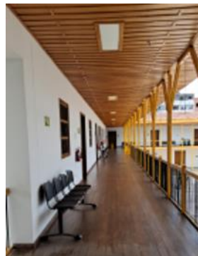
Figura 12. Pasillos del edificio. Fuente: UT T&D Energy
