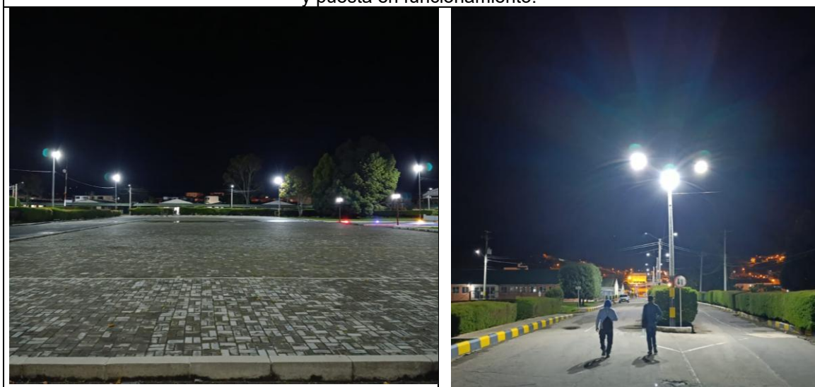
Se realiza encendido, prueba e instalación de reflectores.
