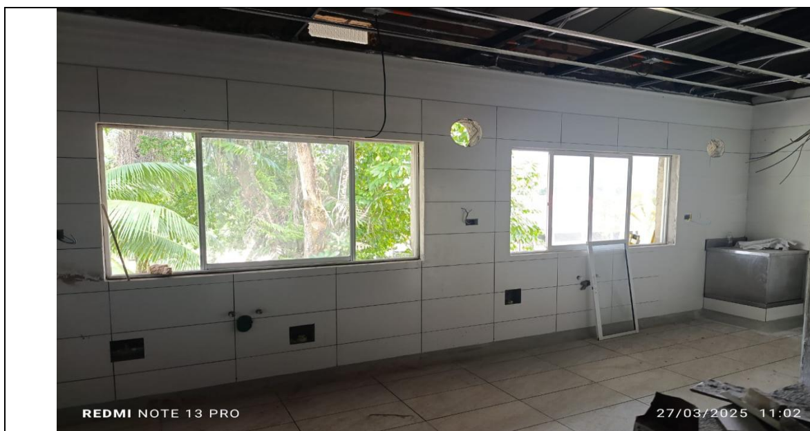
MANTENIMIENTO DE CARPINTERÍA METÁLICA - (PUERTAS Y VENTANAS)
