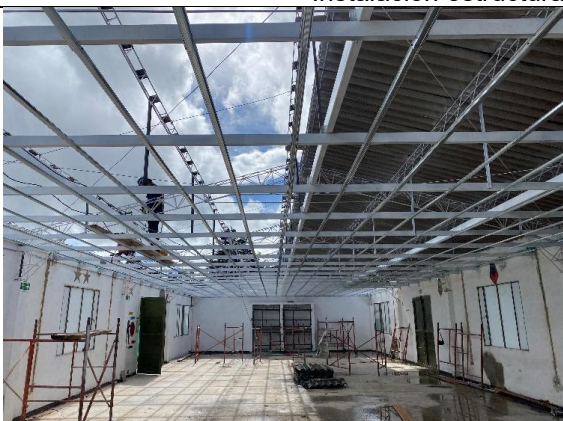
Mantenimiento estructura metálica para cubierta
