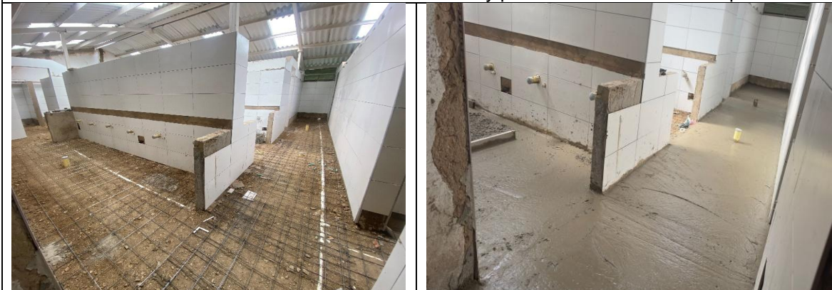
Malla electrosoldada y placa contrapiso en concreto
