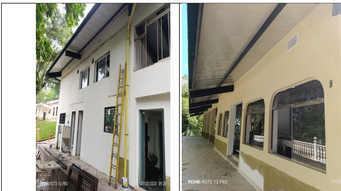
MANTENIMIENTO Pintura Acrílica para exteriores - Limpieza de muros -
