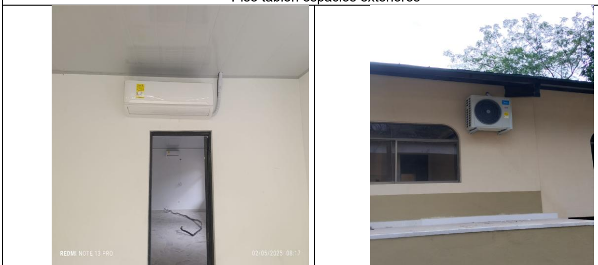
SUMINISTRO, INSTALACIÓN Y PUESTA EN FUNCIONAMIENTO DE AIRE ACONDICIONADO MINISPLIT
