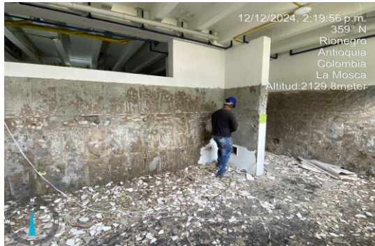
Demolicion de enchape de muros y piso
