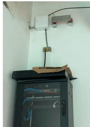
SUMINISTRO, INSTALACIÓN Y PUESTA EN FUNCIONAMIENTO DE PATCH PANEL DE 24 PUERTOS
