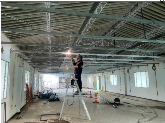
Instalación estructura metálica del cielo raso.
