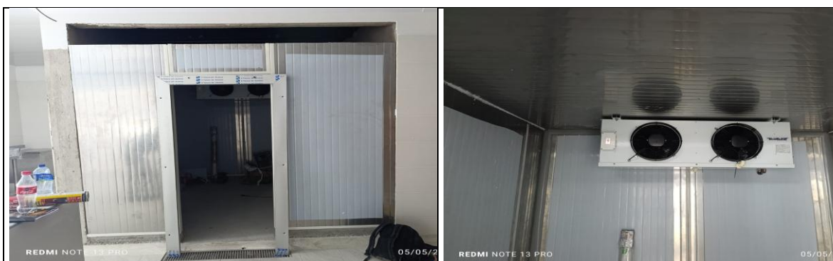
INSTALACIÓN Y PUESTA EN FUNCIONAMIENTO DE CUARTO FRIO PARA CONSERVACIÓN
