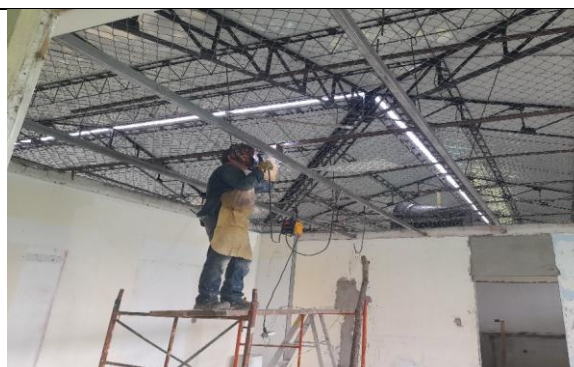
Mantenimiento de la estructura metalica de la cubierta
