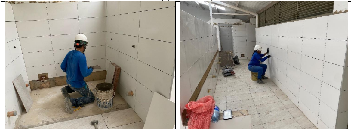
Enchapes de muros y pisos
