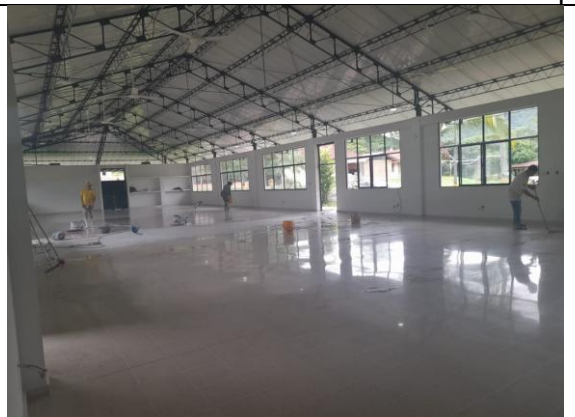
Cambio de piso, instalacion de cielo raso y luminarias,
