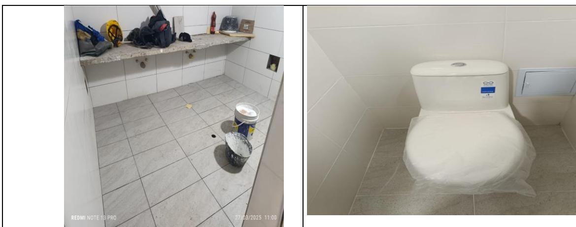
Suministro e instalación de Cerámica para pisos cocina, baños de hombres y mujeres
