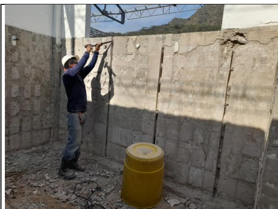
Demoliciones pisos y enchapes
