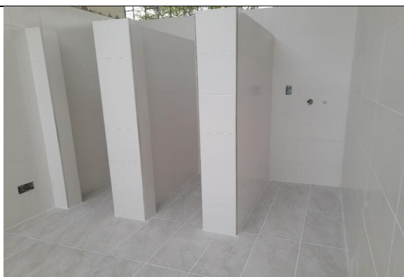
Enchapes y pisos en baños
