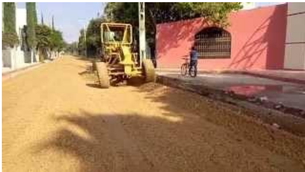
Ilustración 10 Extendido de material granular seleccionada para base del pavimento
