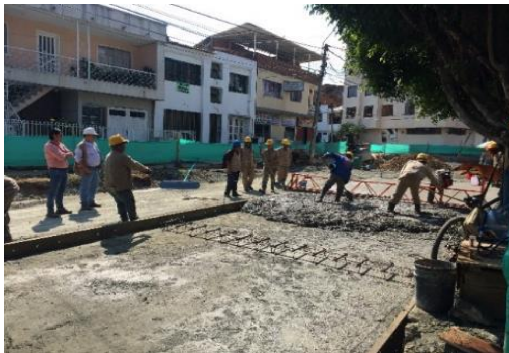
Ilustración 8 Extendido del concreto con regla vibratoria
