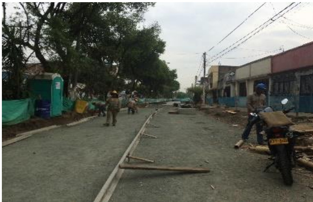
Ilustración 126 instalación formaleta
