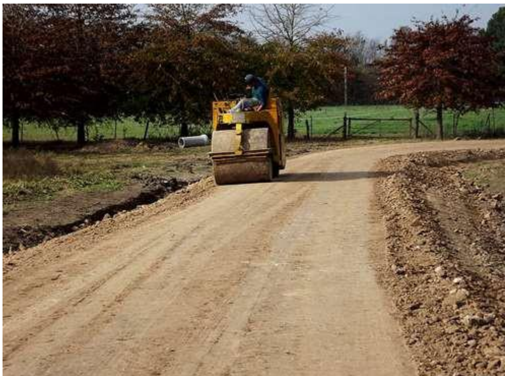
Ilustración 9 compactación de la subrasante para estabilizar el suelo de fundación
