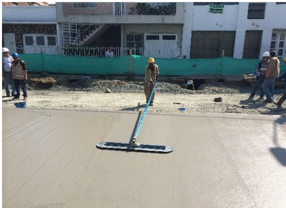
Ilustración 16 Flotado del Concreto
