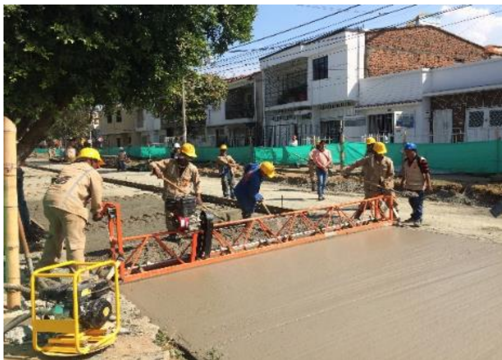
Ilustración 95 extendido del concreto con regla vibratoria
