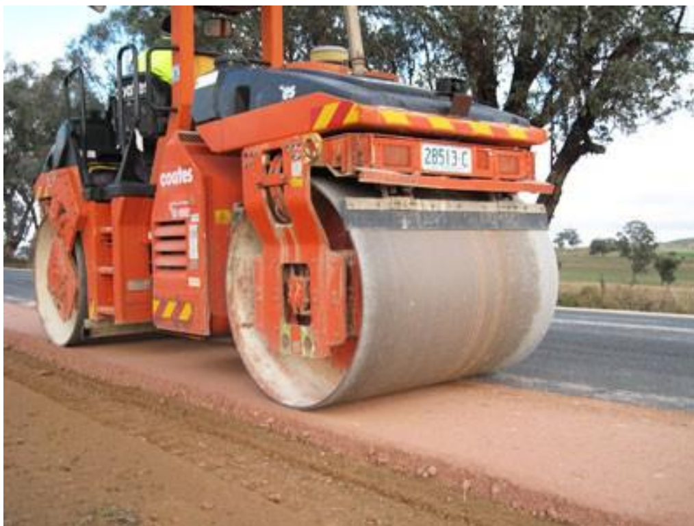
Ilustración 11 Compactando el material extendido para base
