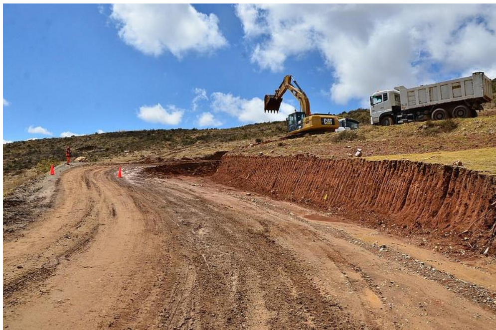
Ilustración 8 movimiento de tierras
