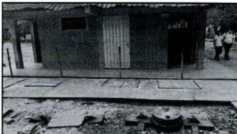
Ilustración 2. Estado actual de la institución
