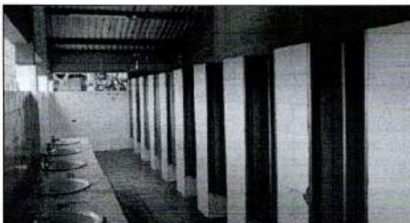
Ilustración 1. Estado actual de la institución
