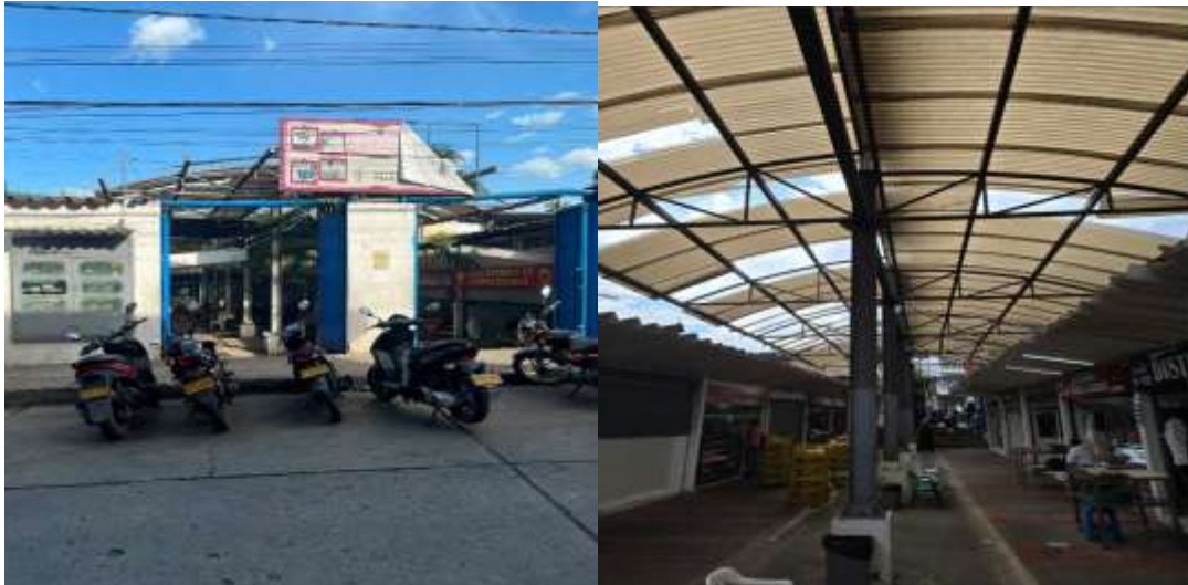
Canal defectuosa Fuente: Elaboración propia
