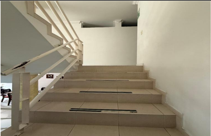
(Escalera de Acceso a Piso 2 Homas )
