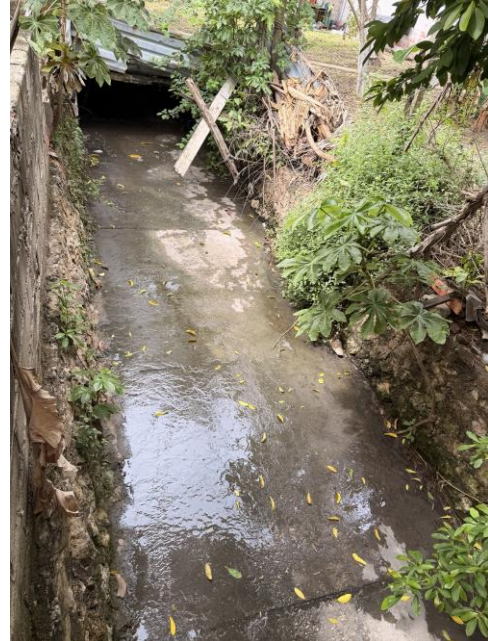
El Carmen – Fotografía 2. Continuidad del canal expuesto y condiciones ambientales del entorno.
