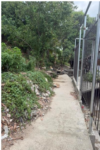
San Martín – Fotografía 3. Condiciones del canal y área de circulación.
