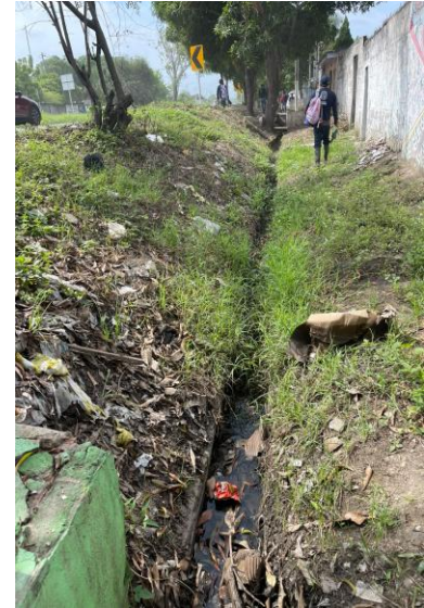
Fotografía Candelaria I – Parque de la Prosperidad. 8. Vista general del canal abierto en el entorno del parque, con vegetación, residuos y presencia de agua en el fondo.
