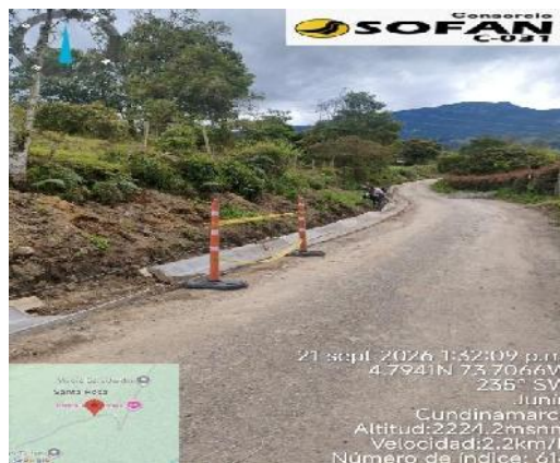
SEÑALIZACION EN OBRA
