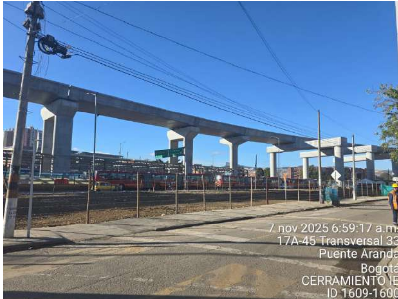
Fotografía 5 - Recibo a satisfacción Inter estación 8 Fuente: Consorcio Demoliciones MV
