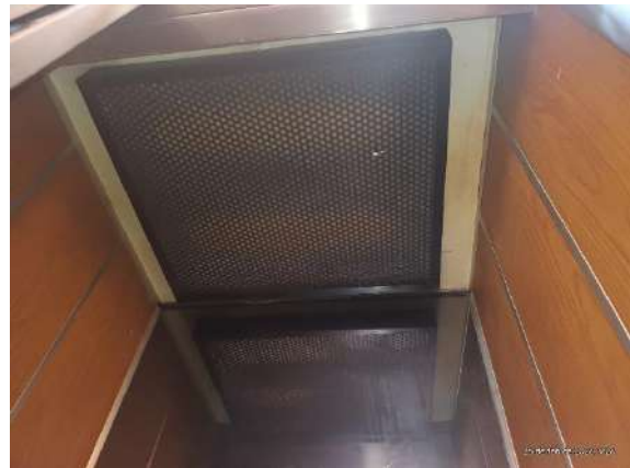
CIELO RASO CABINA
