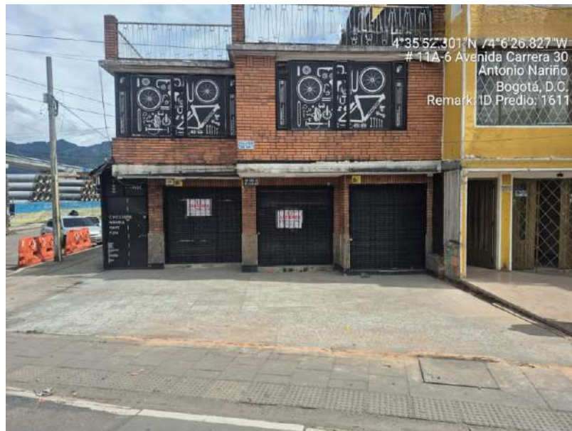
Fotografía 8 - Recibo a satisfacción Inter estación 9 Fuente: Consorcio Demoliciones MV
