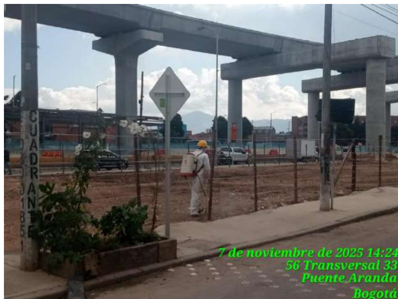
Fotografía 4 - Recibo a satisfacción Inter estación 8 Fuente: Consorcio Demoliciones MV
