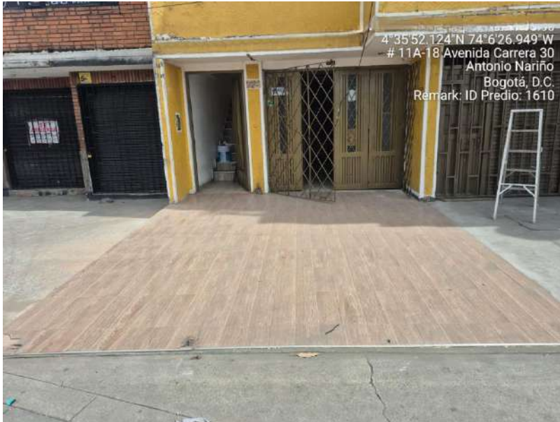
Fotografía 7 - Recibo a satisfacción Inter estación 9 Fuente: Consorcio Demoliciones MV
