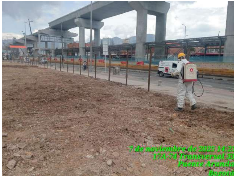
Fotografía 3 - Recibo a satisfacción Inter estación 8 Fuente: Consorcio Demoliciones MV
