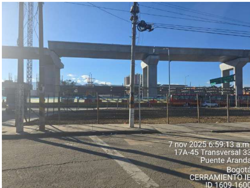
Fotografía 6 - Recibo a satisfacción Inter estación 8 Fuente: Consorcio Demoliciones MV
