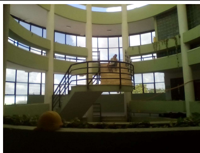
FOTOGRAFIA No. 11: Instalación de Pintura en Muros y Cielo Raso Sede Administrativa
