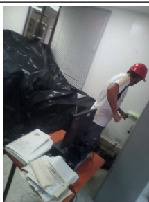
FOTOGRAFIA No. 8: Instalación de Pintura en Muros y Cielo Raso Sede Administrativa
