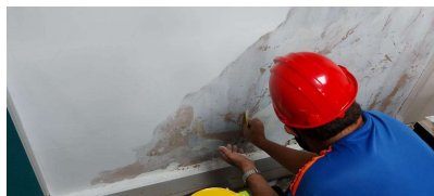
FOTOGRAFIA No. 4: Instalación de Pintura en Muros y Cielo Raso Sede Administrativa
