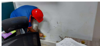
FOTOGRAFIA No. 5: Instalación de Pintura en Muros y Cielo Raso Sede Administrativa
