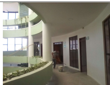
FOTOGRAFIA No. 9: Instalación de Pintura en Muros y Cielo Raso Sede Administrativa
