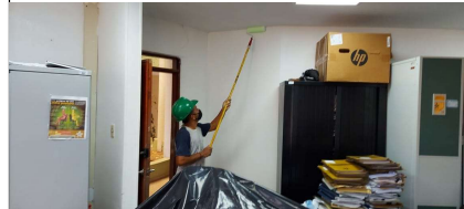
FOTOGRAFIA No. 3: Instalación de Pintura en Muros y Cielo Raso Sede Administrativa
