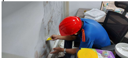
FOTOGRAFIA No. 1: Instalación de Pintura en Muros y Cielo Raso Sede Administrativa
