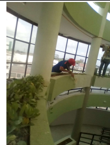
FOTOGRAFIA No. 12: Instalación de Pintura en Muros y Cielo Raso Sede Administrativa
