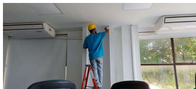
FOTOGRAFIA No. 10: Instalación de Pintura en Muros y Cielo Raso Sede Administrativa
