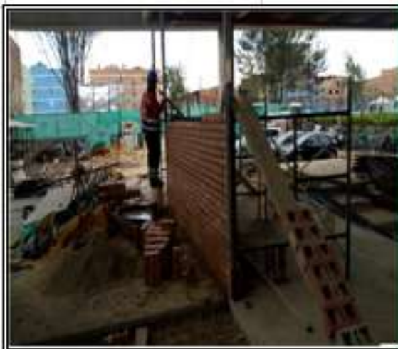
Foto No16: fundida debnaca de celdas 2 piso biblioteca
