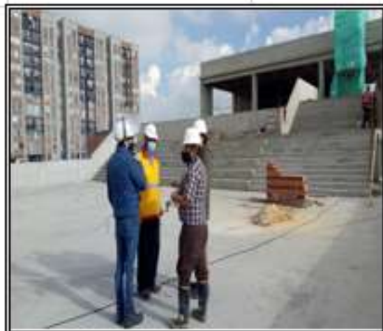
Foto No26 : muro fundido conexión 2-3 1 piso
