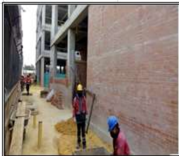
Foto No12: mampostería muros de fachada
