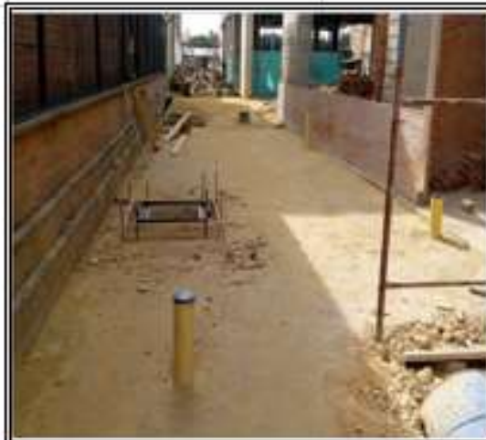
Foto No30: Fundición de rampa sobre localización de cancha principal.
