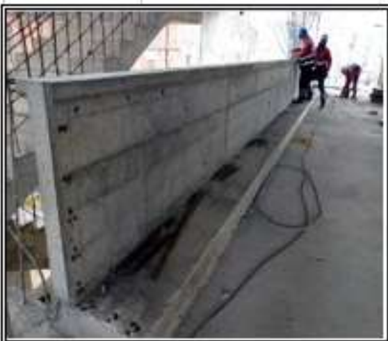
Foto No15: Muro en concreto biblioteca
