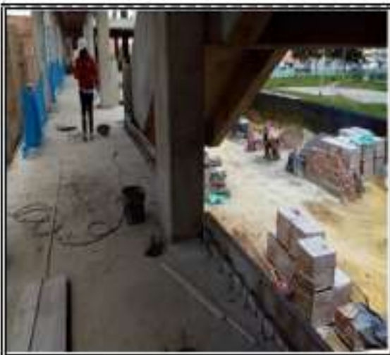
Foto No23: fundida de bordillo cubierta
