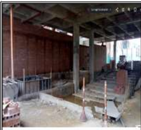
Foto No19 : Mampostería muro interiores y baños 1 piso
