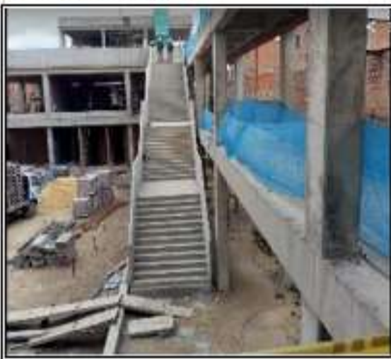
Foto No21: Fundida antepecho Escalera
