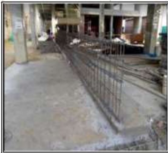
Foto No 6: fundida de placa de contrapiso
