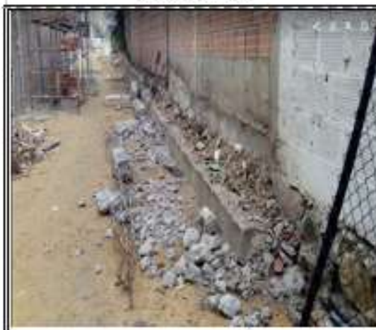
Foto No32 :Demolicion de muro en concreto costado nte
