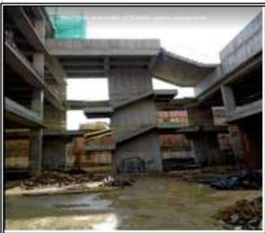
Foto No25 : antepecho cubierta conexión 2-3
