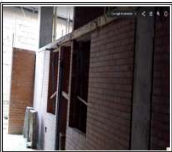
Foto No13: placa dintel 1 piso
