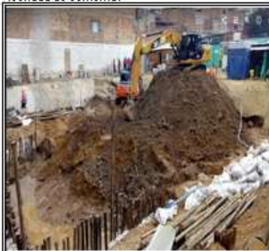
Foto No 4: hincado de postes y excavación de material
