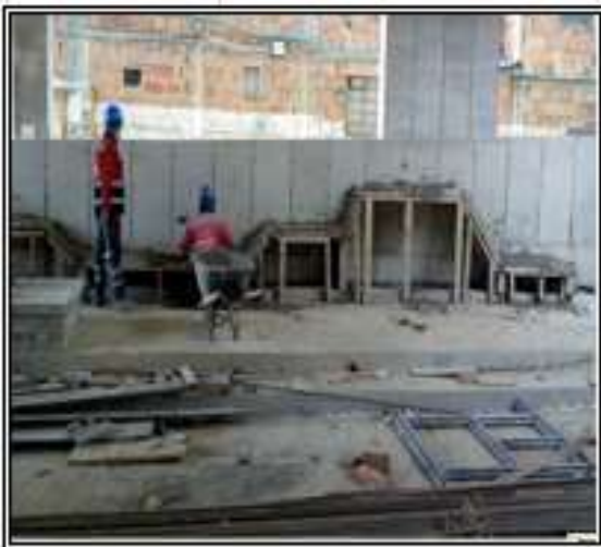
Foto No 5: banca de paneles 1 piso
