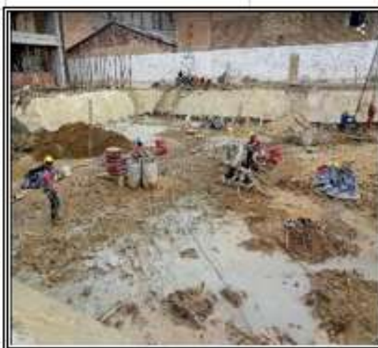
Foto No 2: Tubería instalada para inyección de lechada de cemento.
