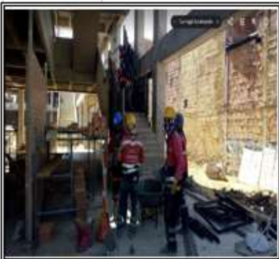
Foto No17: antepecho en concreto escaleras eje A
