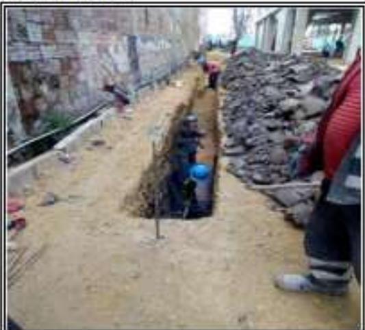
Foto No29: Excavación manual tubería A.N
