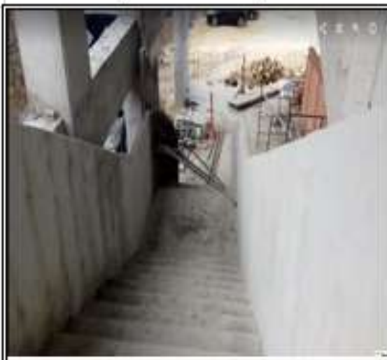
Foto No20: antepecho en concreto escaleras eje A
