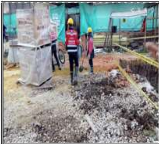
Foto No24 : Excavacion para pozos A.LL sector plazoleta avda tintal
