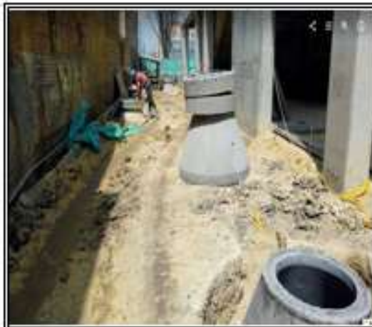
Foto No34: nstalacion de tronco cono de pozos A.N
