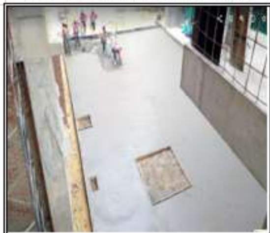
Foto No28 : Fundida de placa de piso plazoleta 2-3
