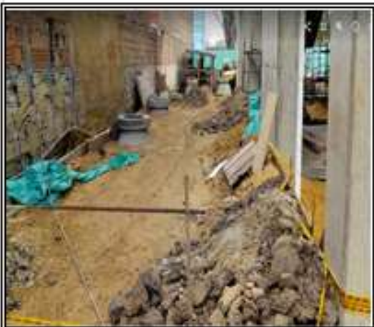
Foto No33: relleno en recebo e instalación geotextil costado nte
