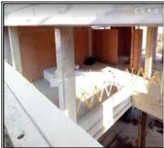
Foto No 8: mampostería muros interiores 2 piso
