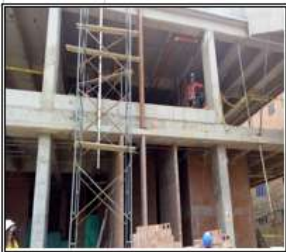
Foto No11: aceros placa dintel salones 1 piso
