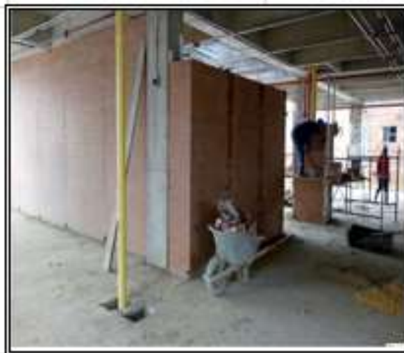
Foto No 10: mampostería muro interiores 2 piso
