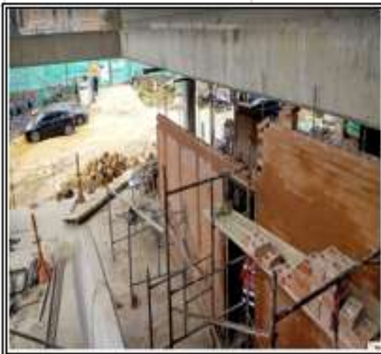
Foto No18: mampostería corredor Eje A
