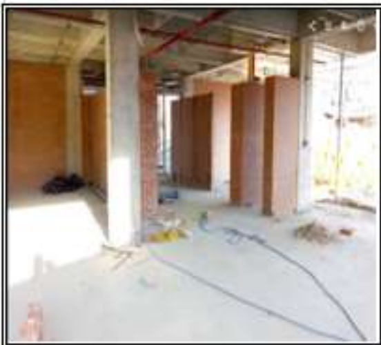
Foto No 7: mampostería muros 2 piso
