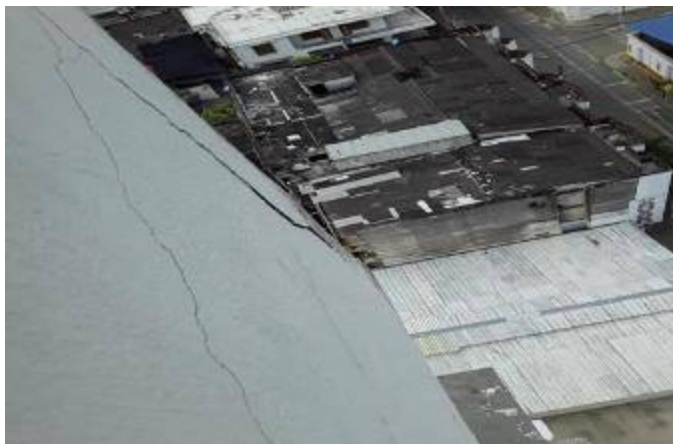
GRIETAS Y SELLOS CON SIKAFLEX
