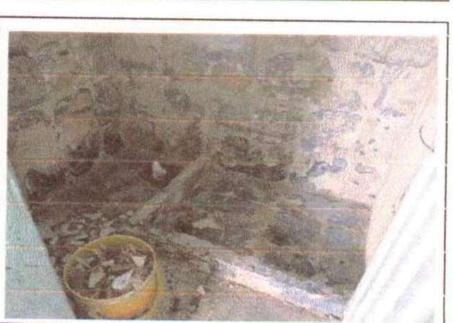
FECHA jueves, 25 de febrero de 2021 DESCRIPCION MV_1588 Avance de obra
