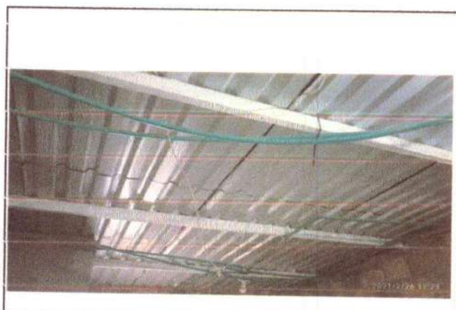
FECHA viernes, 26 de febrero de 2021 DESCRIPCION MV115 0795 ENTREGA DE OBRA
