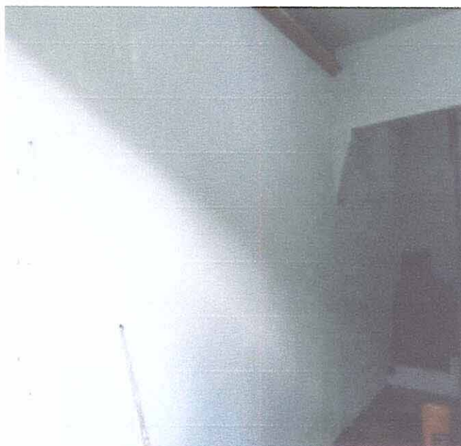
Item 22.1.12 Acabado pintura vinilo mate área garaje
