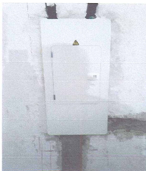
Item 10.2.3.21 Instalación de Tablero Trifásico de Distribución de 18 Circuitos con puerta
