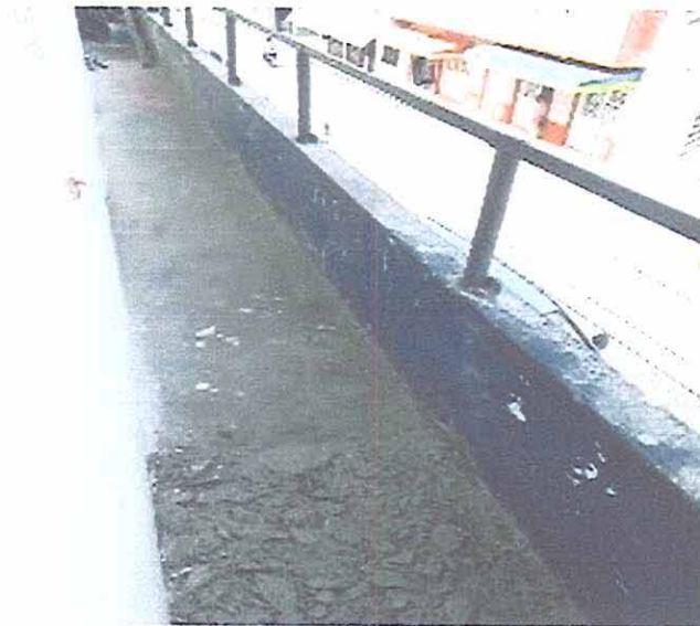
Item 1.3.5.8 Demolición manual de alisado de piso
