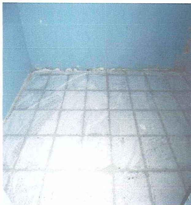
Item 14.2.3.3 Acabado de piso con Baldosa en grano de mármol, bodega.
