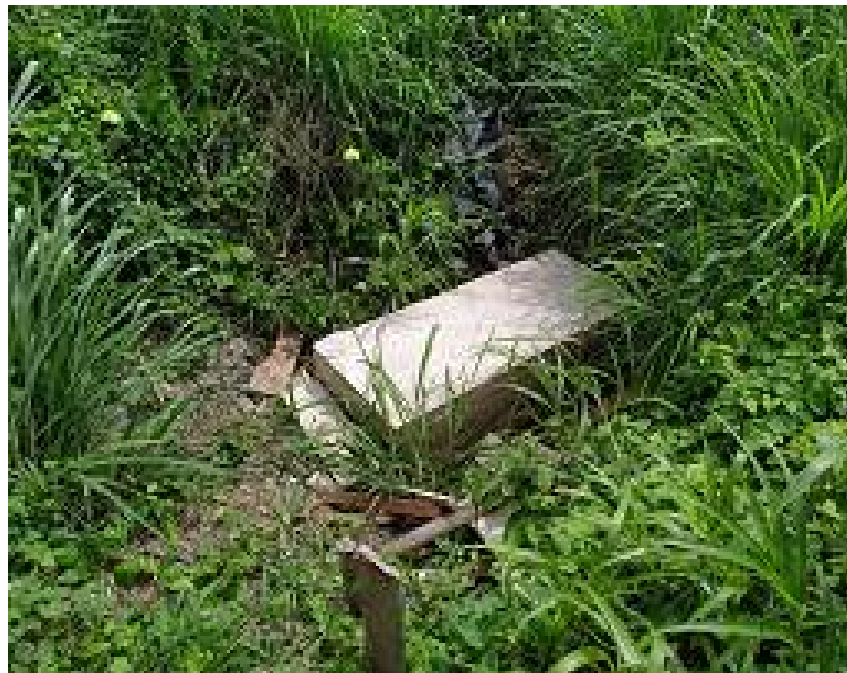
N59 MUROS (CÁMARAS DE INSPECCIÓN)
