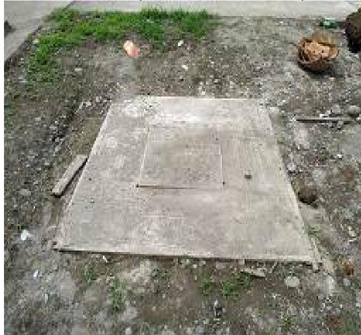
N59 MUROS (CÁMARAS DE INSPECCIÓN)
