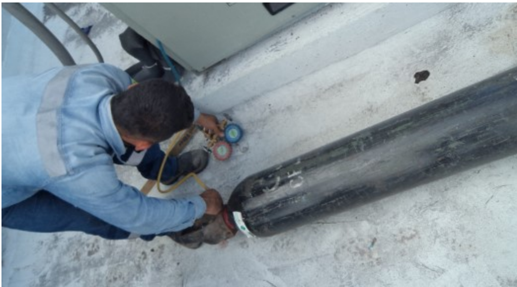
Cargando el sistema de refrigeracion
