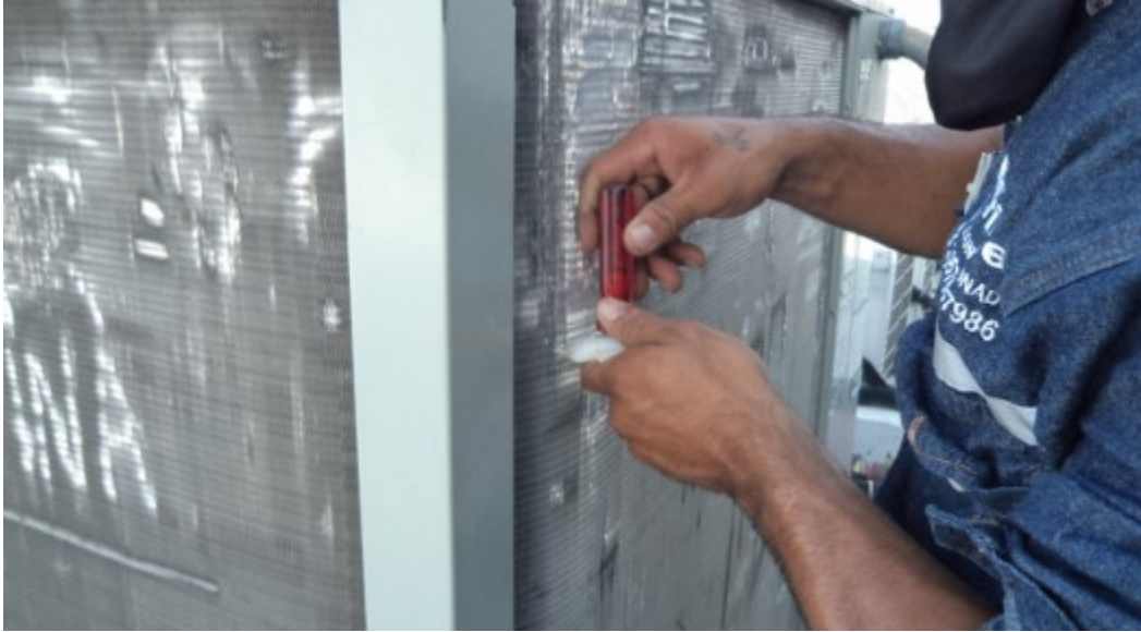
Aplicando sellantes y soldadura
