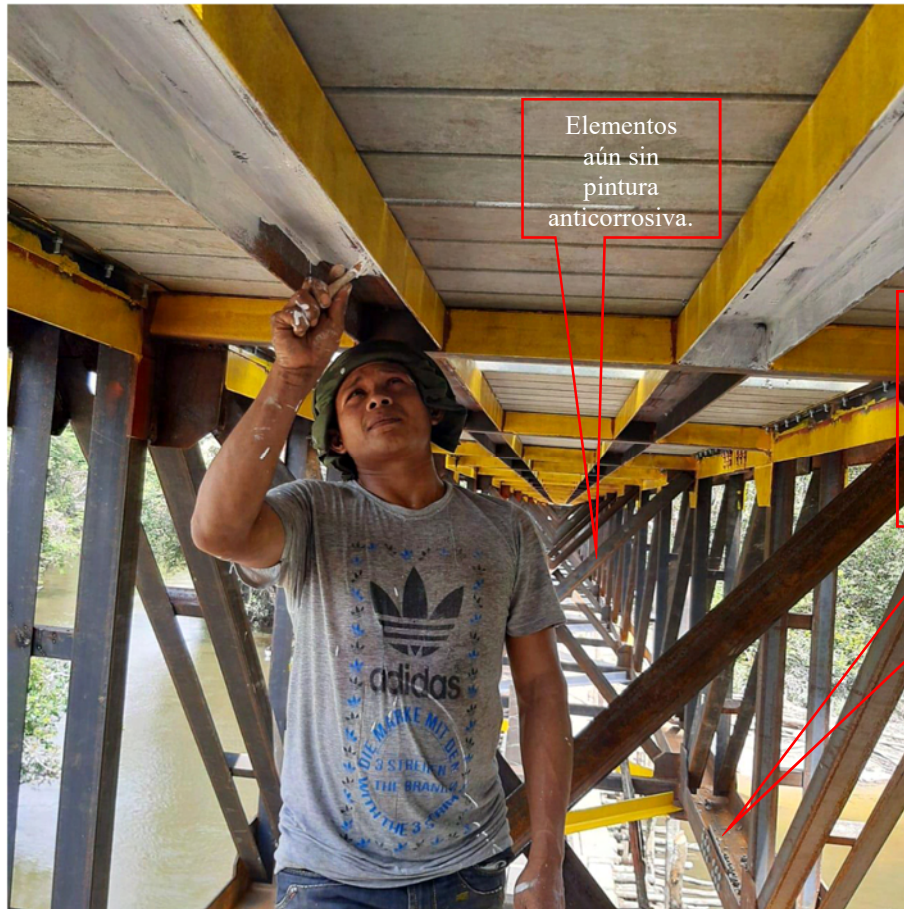
Foto 1 - Proceso de Pintura en campo.
