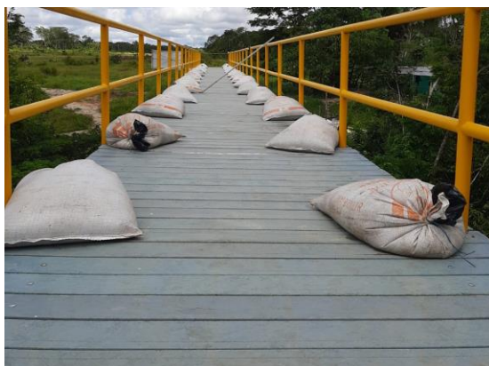
Proceso de carga con lonas de agua.
