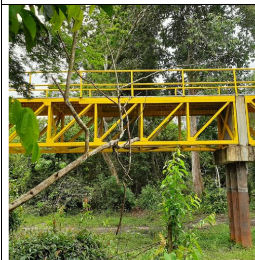
Superestructura Puente peatonal
