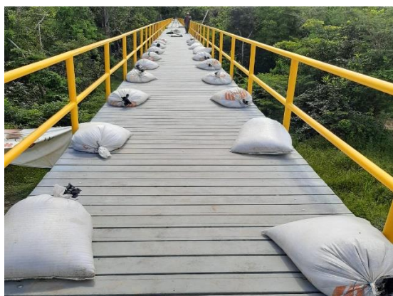
Inicio de carga con lonas de agua.
