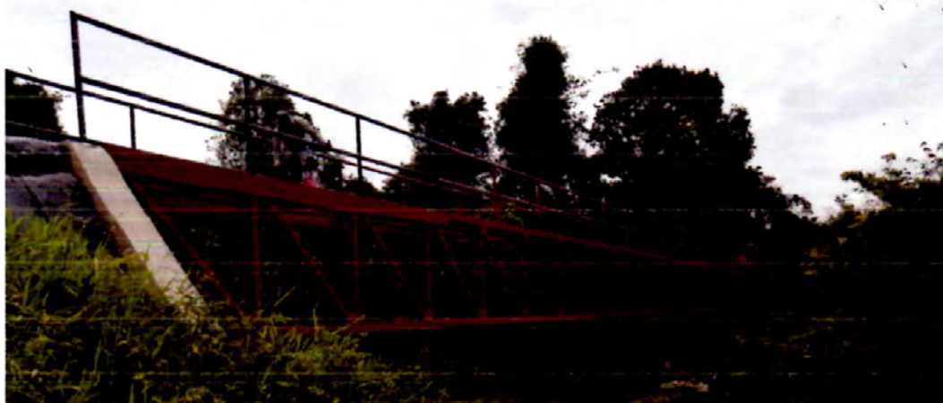
APLICACION DE ANTICORROSIVO ESTRUCTURA METALICA
