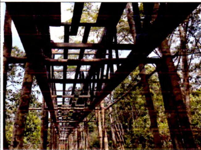
COLOCACION RIOSTRADO PARTE INFERIOR
