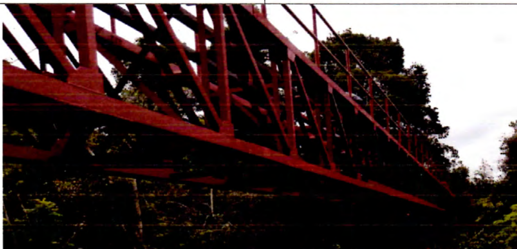
VISTA LATERAL ESTRUCTURA PUNTE LUZ N° 3
