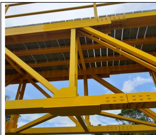
Superestructura Puente peatonal
