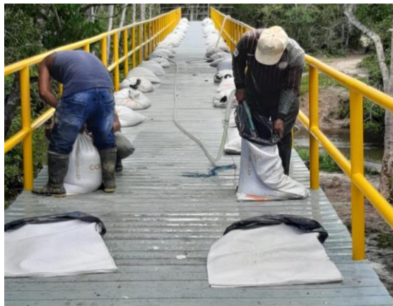
Proceso de carga con lonas de agua.
