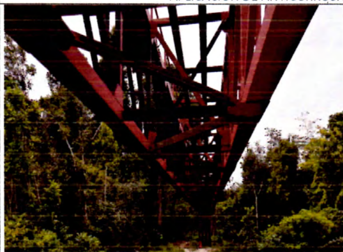
VISTA INFERIOR ESTRUCTURA LUZ N° 2
