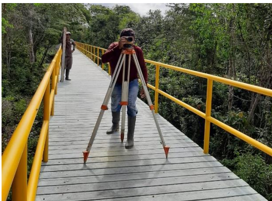
Toma de datos finales luego del proceso de carga y descarga.
