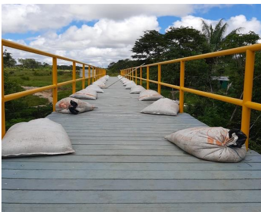
Inicio de carga con lonas de agua.
