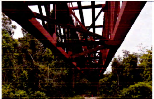
VISTA INFERIOR PUENTE
