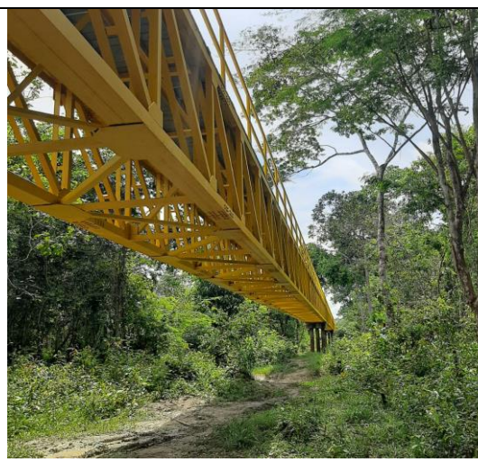
Superestructura Puente peatonal
