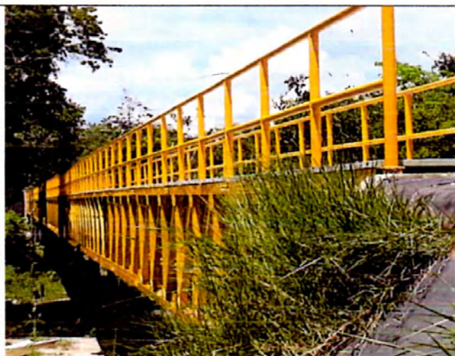
VISTA LATERAL ESTRUCTURA PUNTE LUZ N° 1
