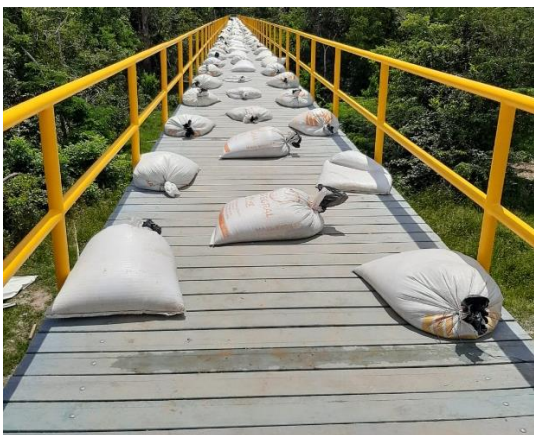
Inicio de descarga etapa 3
