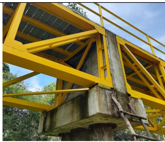
Superestructura Puente peatonal
