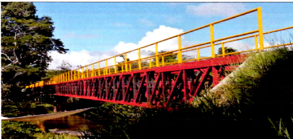
VISTA LATERAL ESTRUCTURA PUENTE LUZ N° 1
