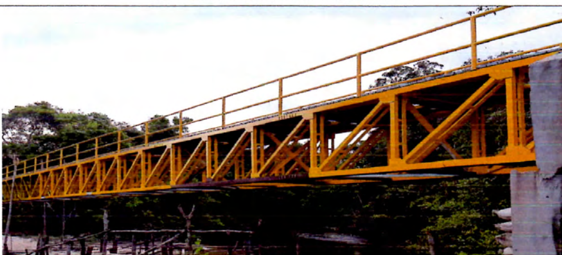
VISTA LATERAL ESTRUCTURA PUENTE LUZ N° 4
