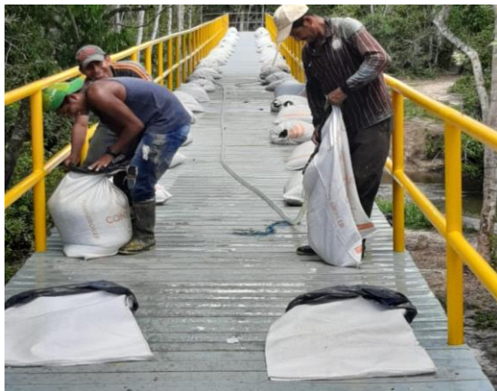
Proceso de carga con lonas de agua.
