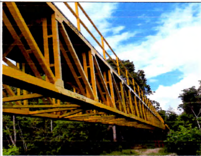
VISTA LATERAL ESTRUCTURA PUNTE LUZ N° 1
