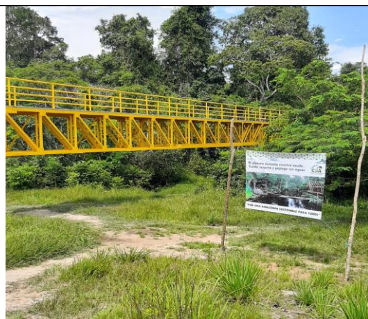
Superestructura Puente peatonal
