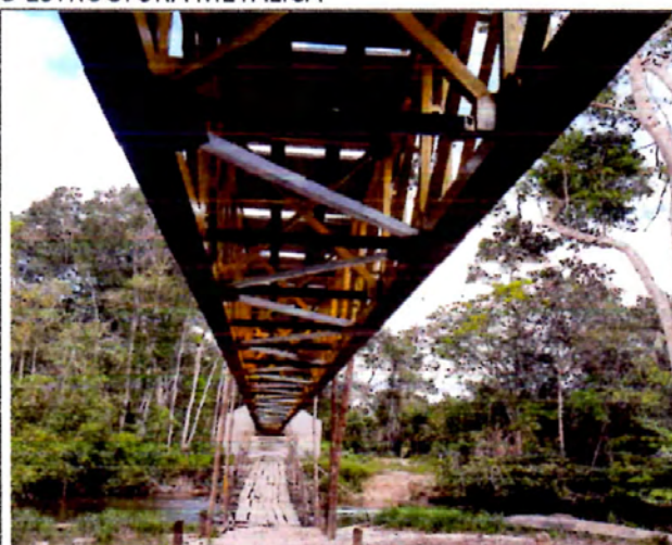
VISTA INFERIOR ESTRUCTURA LUZ N° 4
