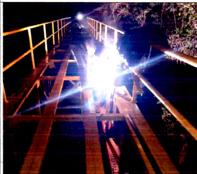
SOLDADURA ELEMENTOS PARTE SUPERIOR
