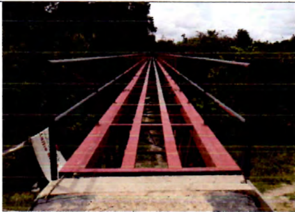
ACCESO PUENTE K0+000
