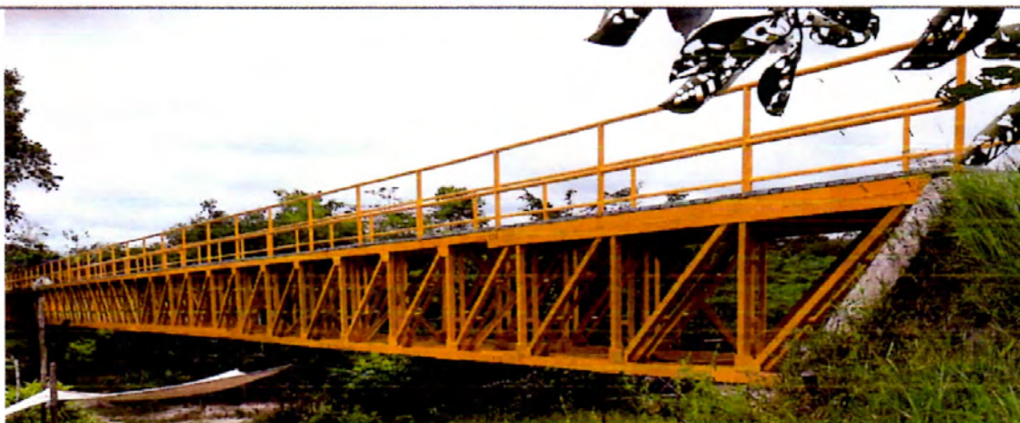
VISTA LATERAL ESTRUCTURA PUENTE LUZ N° 1
