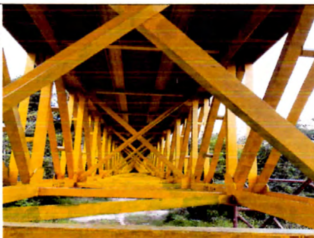
VISTA INFERIOR RISOTRADO PUENTE
