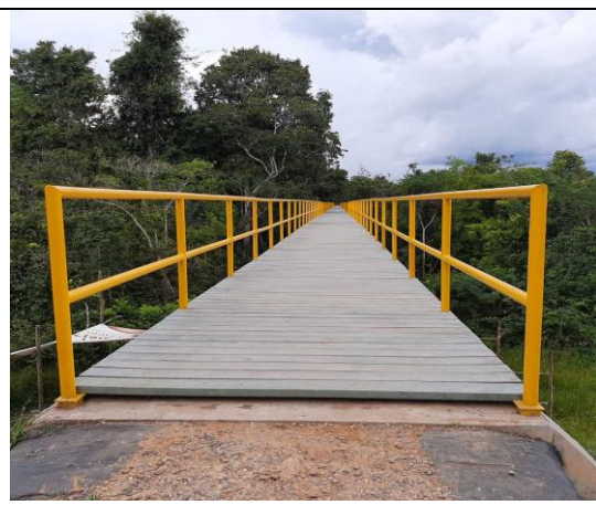
Instalación placa maderplast
