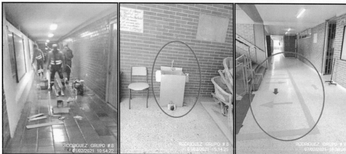
REGISTRO FOTOGRÁFICO ADECUACION DE INSTALACIONES EN LAS SEDES EDUCATIVAS
