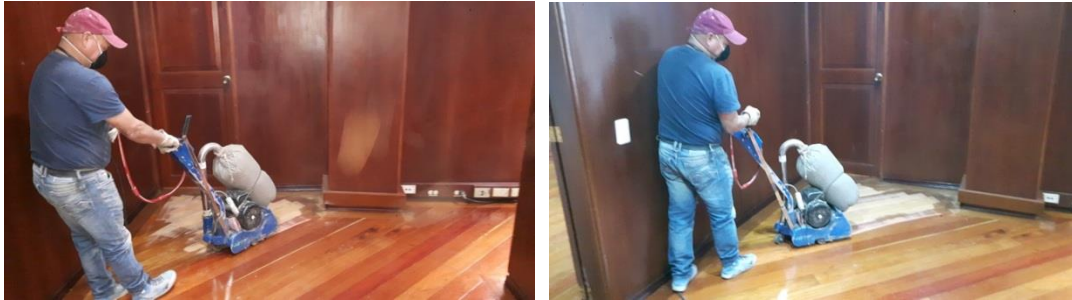
Fotografía 4 Lijado del piso
