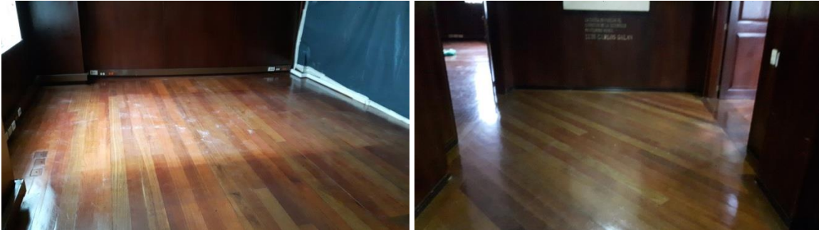
Fotografía 1 Estado Inicial del piso salón 1 y entrada al despacho
