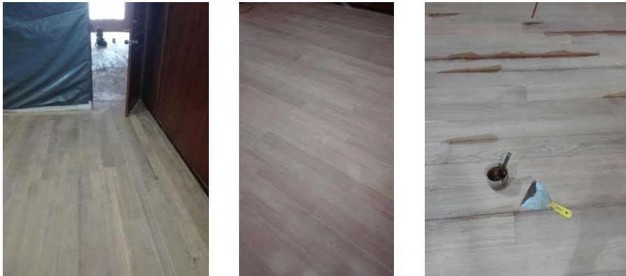
Fotografía 5 Piso totalmente lijado y aplicación de macilla
