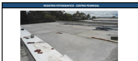
Fundición de alisto en cubierta edificio de escuela, para impermeabilización.
