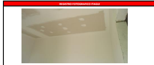
Instalación de Drywall, en cielo falso de caniles. (alojamientos).
