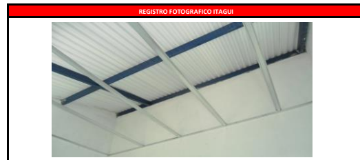
Instalación de perfilera para soporte de Drywall, cielo falso alojamientos guardia caniles.
