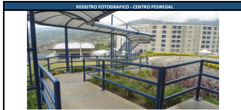
Mantenimiento de estructura en senderos, entre portales No1 y No2.
