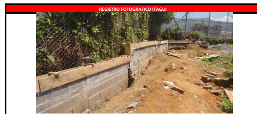
Instalación de bloque, y formaleta para viga intermedia en muro de cerramiento perimetral en zona de caniles.
