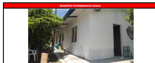
Continuación con pintura fachada de caniles.
