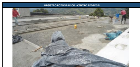
Fundición de alistas para impermeabilización de cubiertas, frente edificio de escuela.
