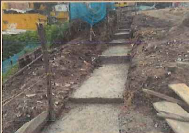
CONCRETO DE LIMPIEZA EN ZONA DE MURO
