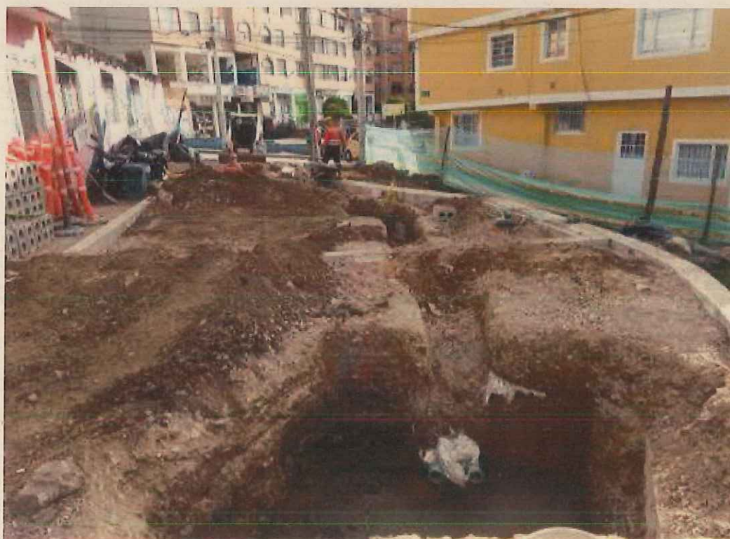
Foto excavaciones cajas eléctricas e instalacion de tuberia
