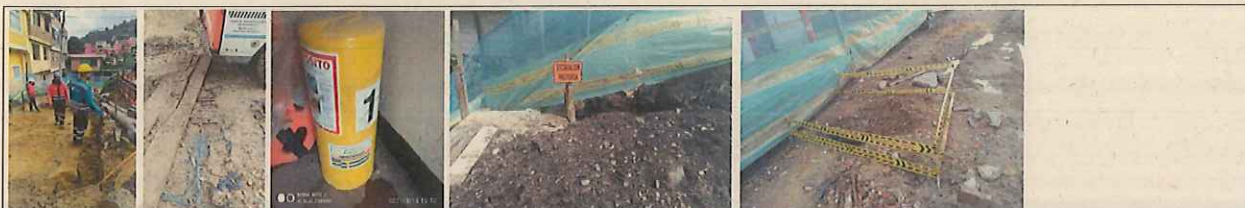
17/03/2021 SEGUIMIENTO ESTADO CAMPAMENTO, CARGUE Y DESCARGUE DE MATERIAL, SENDEROS PEATONALES, PROTOCOLO BIOSEGURIDAD, SEÑALIZACION
