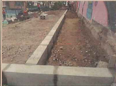
CONCRETO DE LIMPIEZA EN ZONA DE MURO
