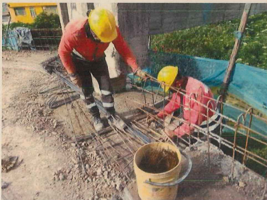
Foto avance muro de contención junto a puente peatonal
