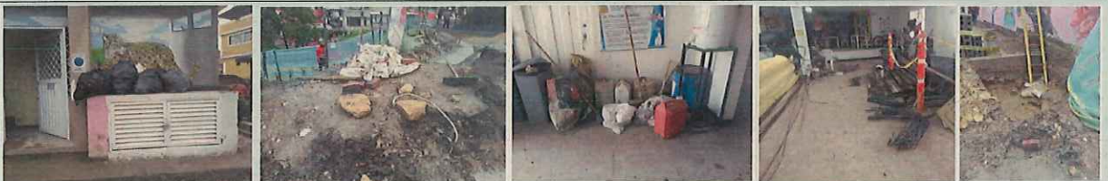
13/03/2021 SUBSANACIONES REALIZADAS POR EL CONTRATISTA
