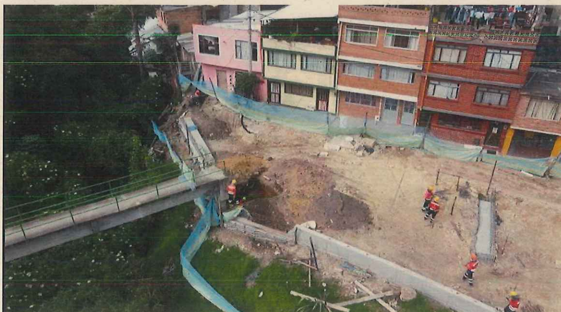
Foto vista aérea avance general
