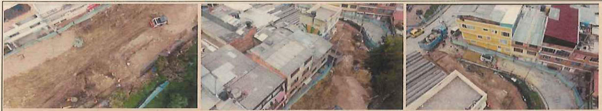
INSTALACION DE BORDILLO EN COSTADO OCCIDENTAL
