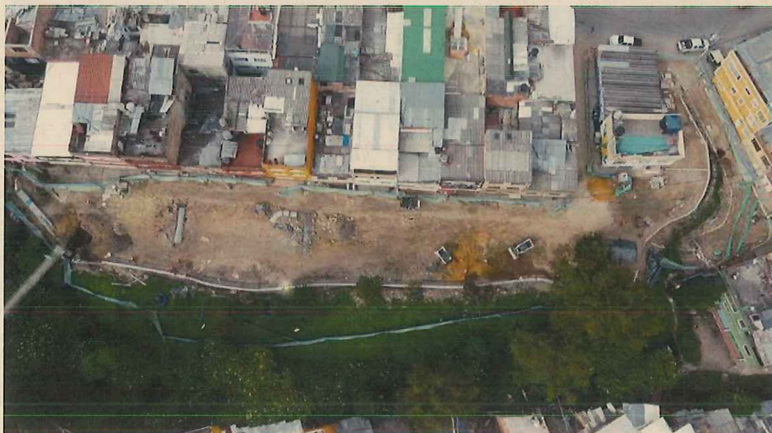
Foto vista aérea avance general
