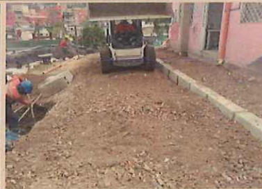
AVANCE INSTALACION DE BORDILLO EN CARRERA STA
