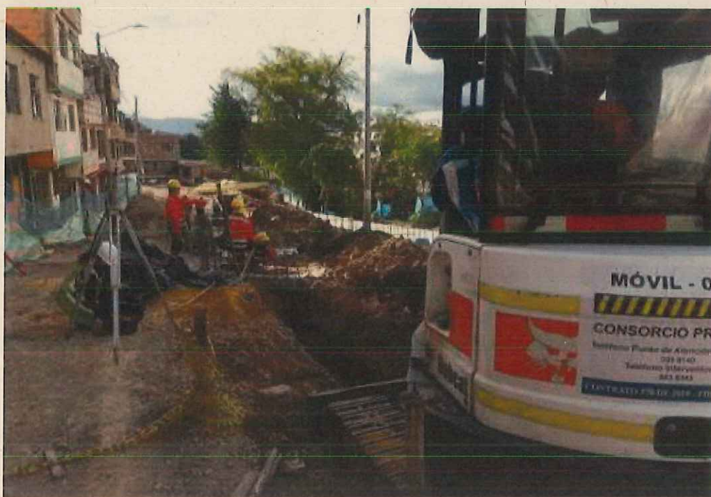
Foto excavacion tubería eléctrica en zona de gimnasios
