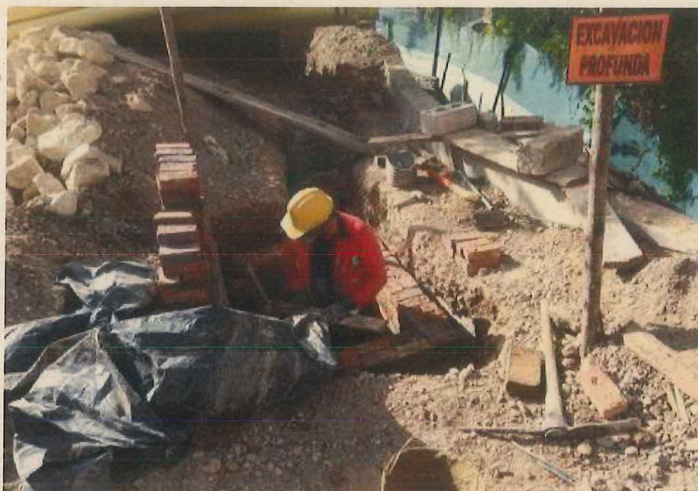
Foto construcción de cajas eléctricas
