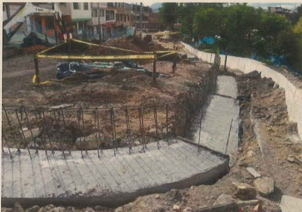
Foto zarpa muro de contención en zona de gimnasios
