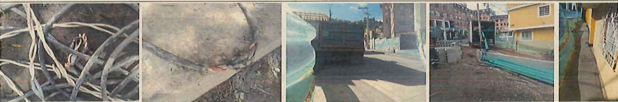
20/03/2021 SEGUIMIENTO CERRAMIENTOS, SEÑALIZACION PMT SENDEROS PEATONALES, PROTECCION SUMIDEROS, ORDEN Y ASEO
