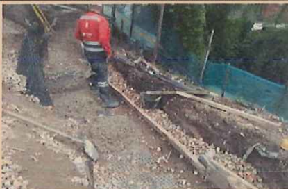
PROCESO DE INSTALACION DE CONCRETO DE LIMPIEZA
