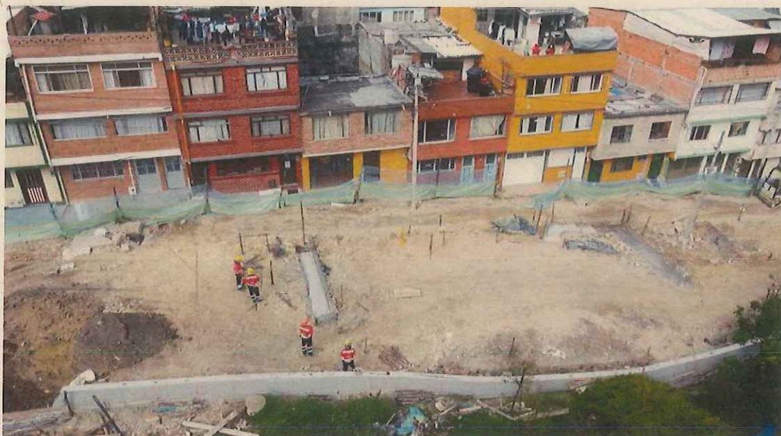
Foto vista aérea avance general
