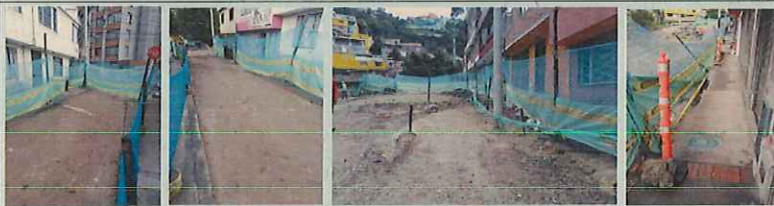
13/03/2021 SEGUIMIENTO CERRAMIENTOS, SEÑALIZACION ACOPIOS, CERRAMIENTOS, CAMPAMENTO SUMIDEROS, ORDEN Y ASEO
