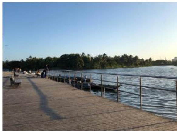
Imagen 7. Pasamanos existente muelle INTENDENCIA FLUVIAL
