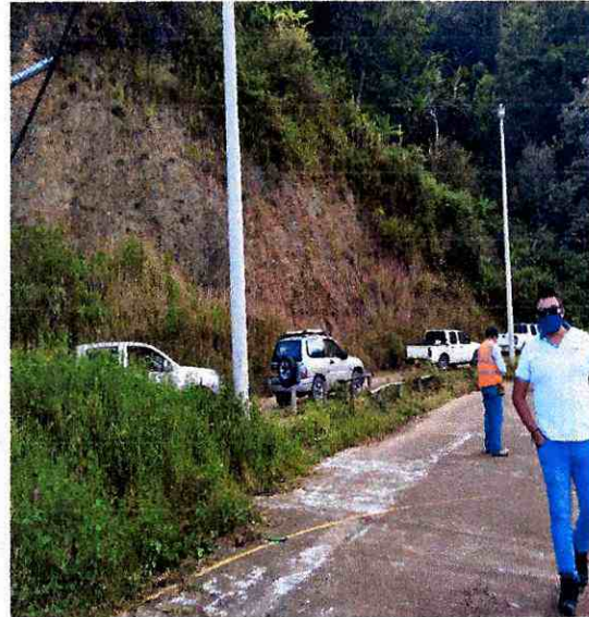
Foto 13: Sector Puente Via Agrado
