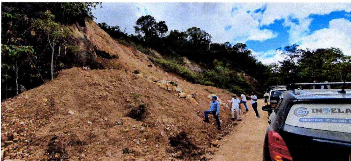
Foto 5: Sector de la Vía Agrado
