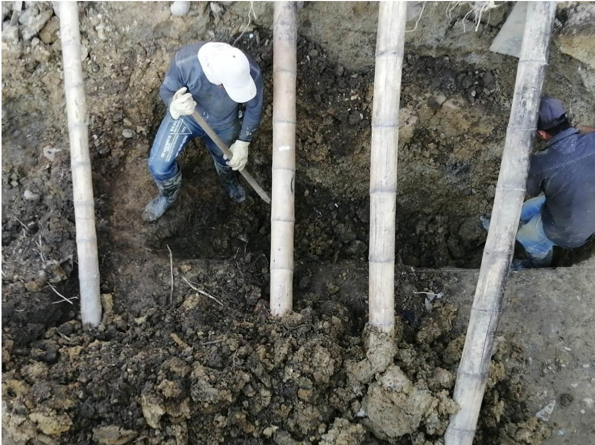
Excavación manual en material común.
