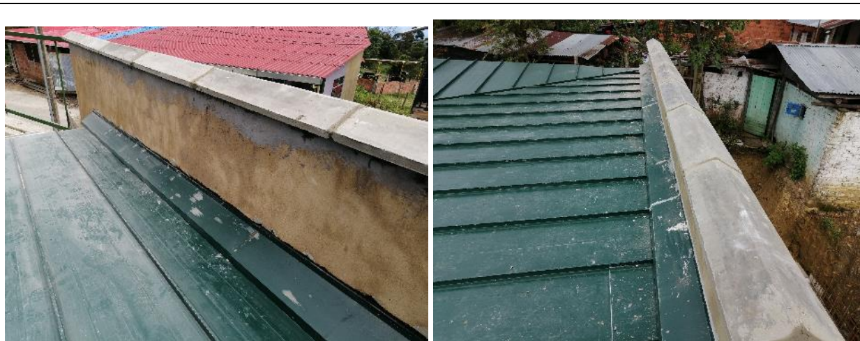
Alfajía Prefabricada en concreto de 2500 psi de 1,00 m de largo o similar.
