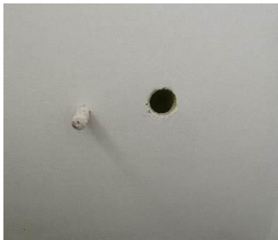
Puntos Hidráulicos y Salidas Sanitarias.
