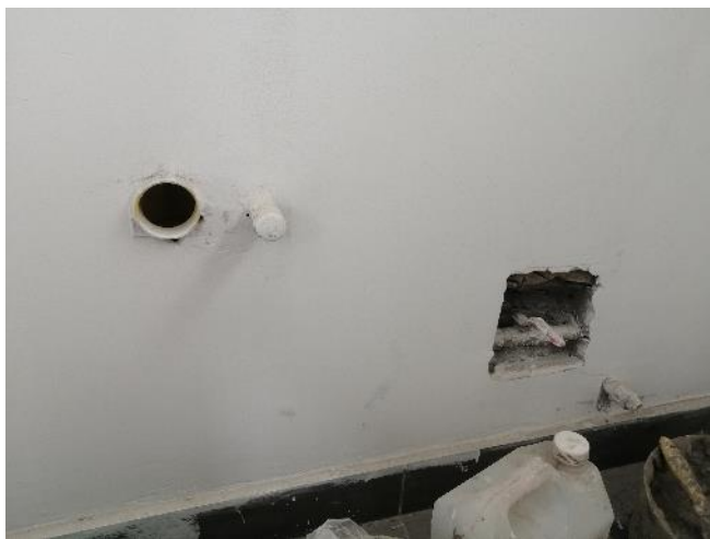
Puntos Hidráulicos y Salidas Sanitarias.
