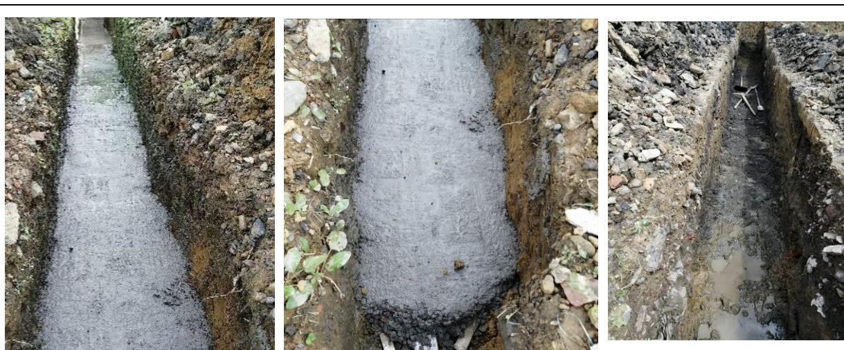
Suministro y colocación de concreto de 2000 psi y e=0.05\text{m} como superficie protectora.
