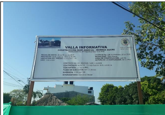
Instalación de valla informativa.
