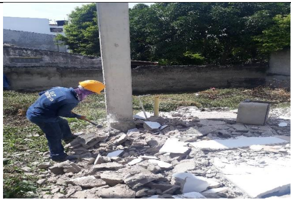
Demolición estructura tanque elevado existente.
