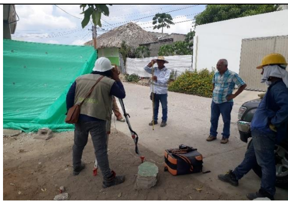
Nivelación de terreno.
