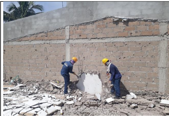
Demolición de muros existentes.
