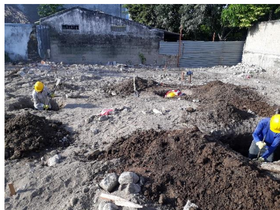
Excavación manual para cimentación.
