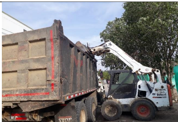
Cargue y retiro de escombros.
