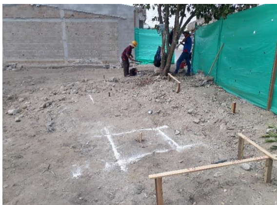
Trazado de zapatas con cal.
