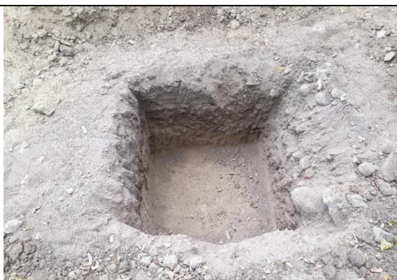
Excavación manual en roca.
