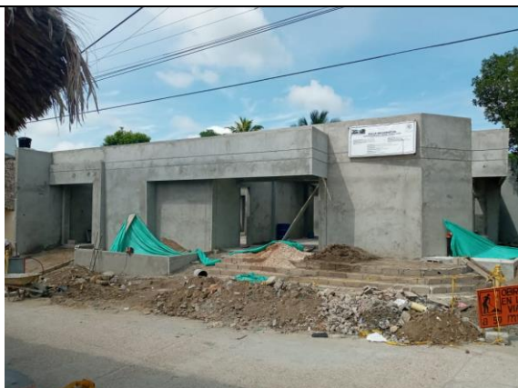
Vista avance general de la obra.
