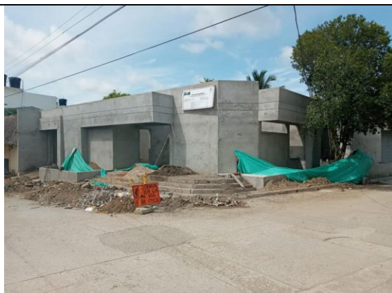
Vista avance general de la obra.
