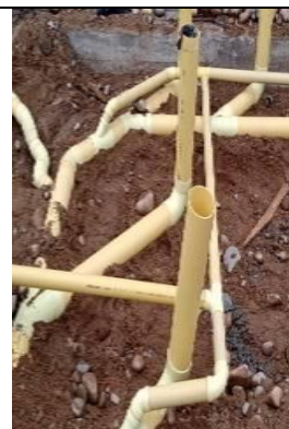
Tubería novafort 4" y 6" (enterrada) Red aguas negras Módulo 1.
