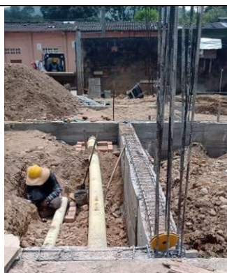
Tubería novafort 4" y 6" (enterrada) Red aguas negras Módulo 1.
