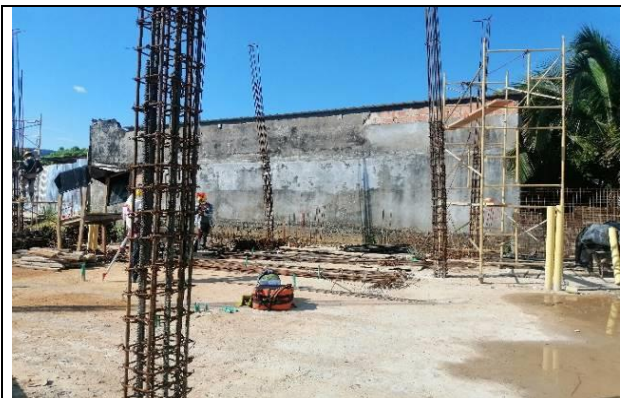
Acero de refuerzo 60.000 psi - Columnas Módulo 1.
