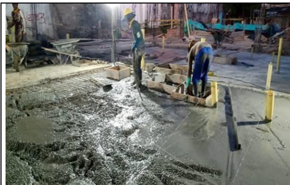
Placa de contrapiso en concreto e > 10 \leq 12,5 cm f'c = 3000 psi. Incluye polietileno cal.4 negro en doble capa.
