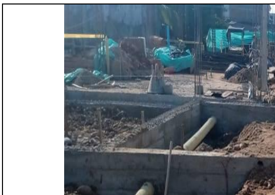
Tubería novafort 4" y 6" (enterrada) Red aguas negras Módulo 1.
