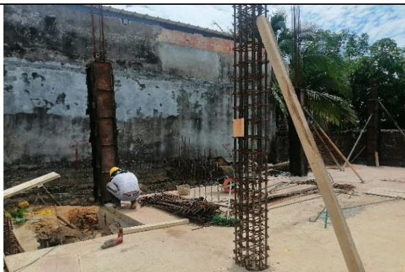
Acero de refuerzo 60.000 psi - Columnas Módulo 1.
