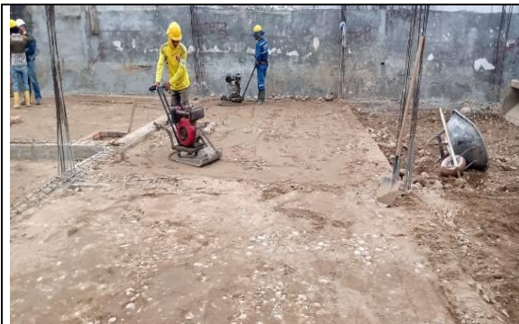
Relleno compactado a mano en sub-base granular SBG-1 INVIAS ART. 320 Gradación según estudio de suelos numeral 5.3. Incluye extendido, humedecimiento y compactación. Módulo 1.
