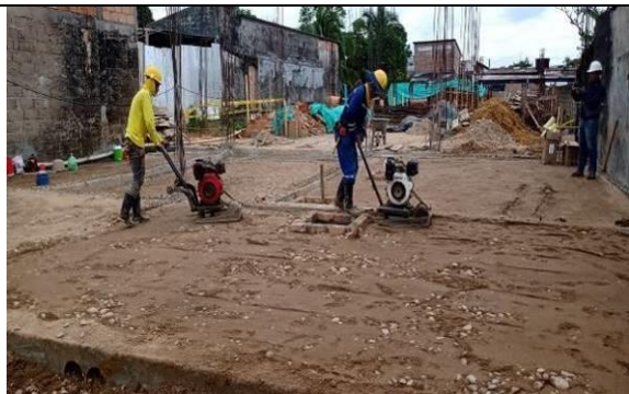
Relleno compactado a mano en sub-base granular SBG-1 INVIAS ART. 320 Gradación según estudio de suelos numeral 5.3. Incluye extendido, humedecimiento y compactación. Módulo 1.
