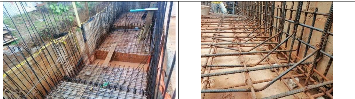
Acero de refuerzo 60.000 psi. – Tanque subterráneo.
