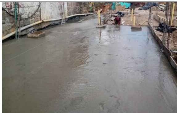
Placa de contrapiso en concreto e > 10 \leq 12,5 cm f'c = 3000 psi. Incluye polietileno cal.4 negro en doble capa.
