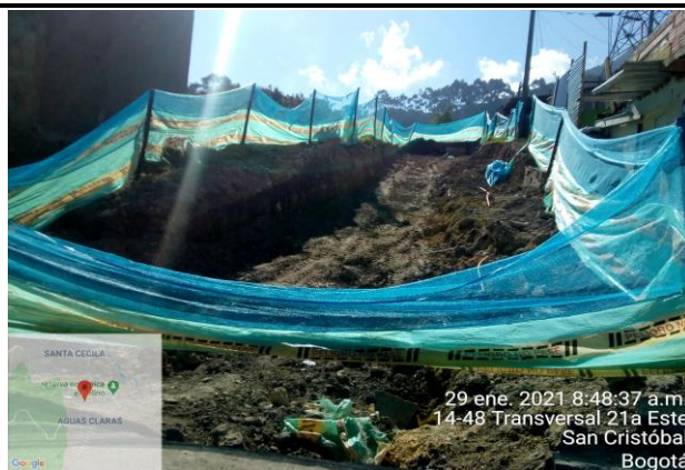
Mejoramiento de cerramiento y senderos peatonales
