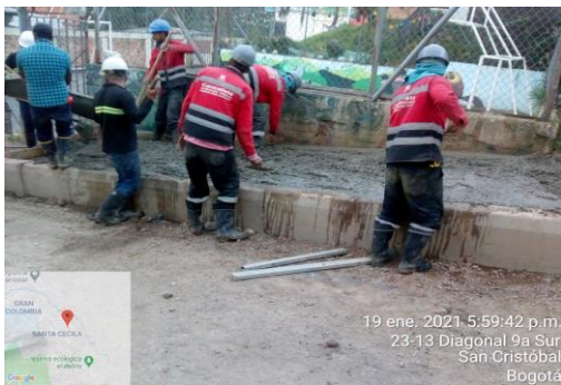
Fundida de concreto en andenes
