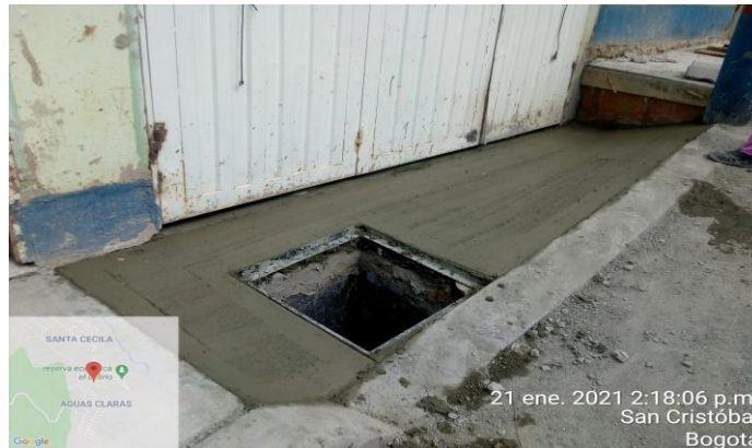
Fundida de rampas
