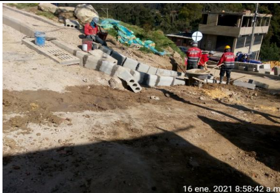
Instalación de Bordillo
