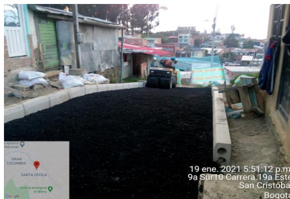
Instalación de Base estabilizada con asfalto
