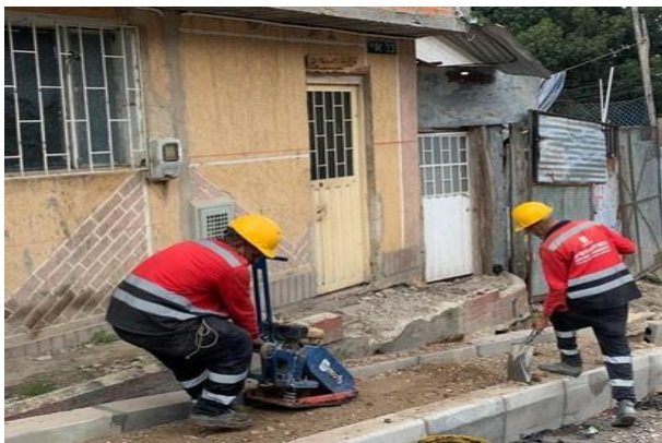
Nivelación y compactación de la Sub base granular en Andenes
