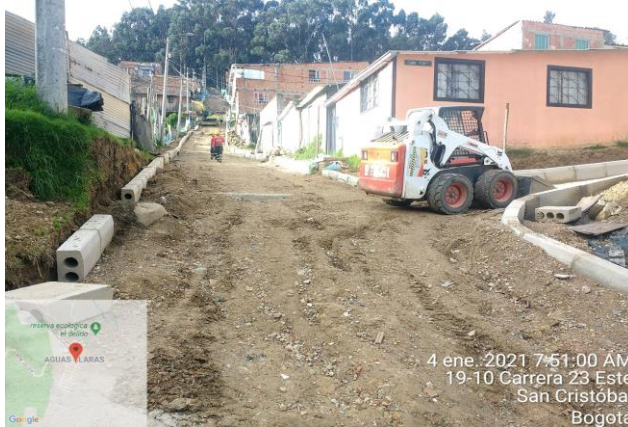
Instalación de Sub base granular
