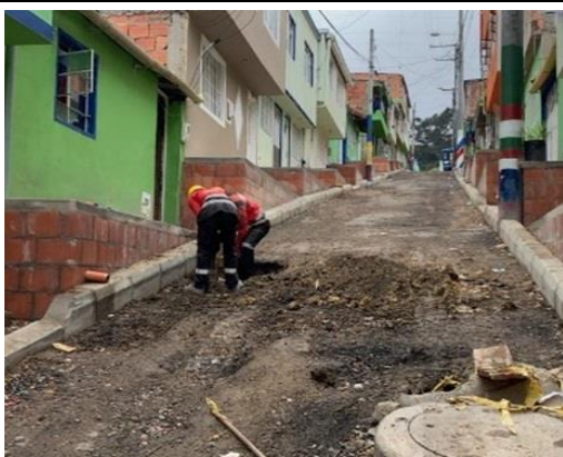
Nivelación y compactación de la Sub base granular en Andenes
