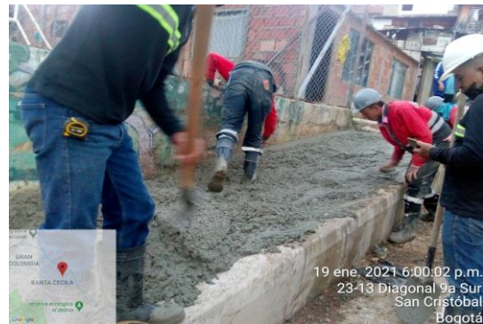
Fundida de concreto en andenes
