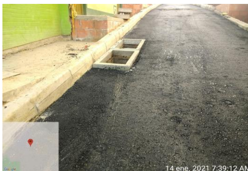
Construcción de sumideros
