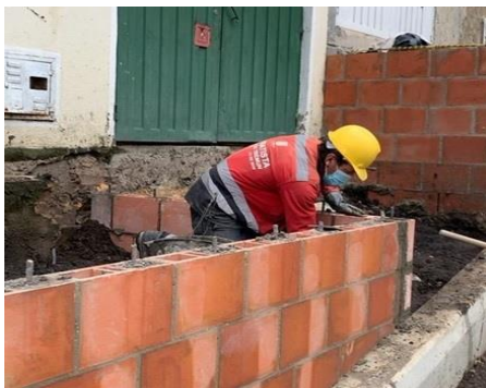
Construcción de Muros Estructurales
