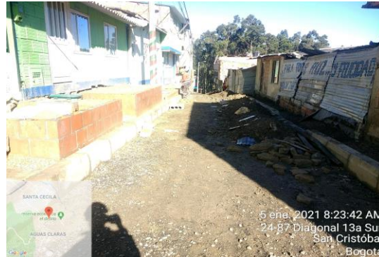
Construcción de Muros Estructurales
