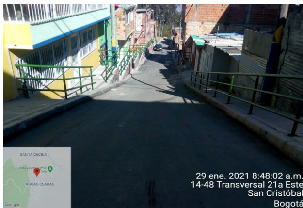
Instalación de Barandas Metalicas
