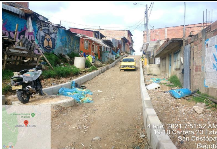
Instalación de Sardinell e Instalación de Sub base Granular
