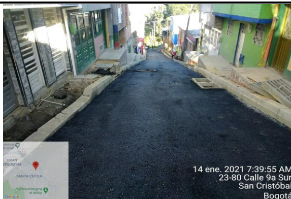
Instalación de Mezcla Asfáltica
