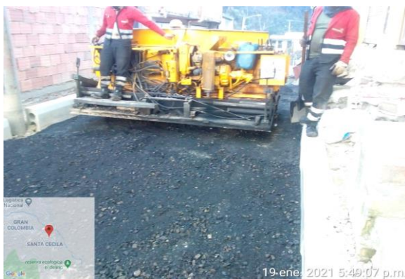
Instalación de Base estabilizada con asfalto
