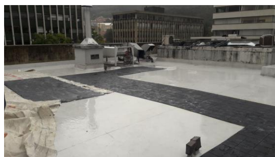
Figura 2, colocación de piso de caucho o llanta de 1 cm de espesor y 1,5m de ancho para sendero de mantenimiento para cubierta alta.
