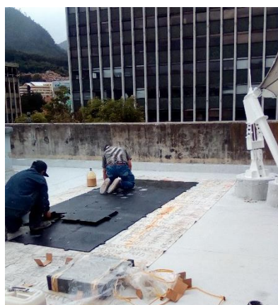
Figura 2, colocación de piso de caucho o llanta de 1 cm de espesor y 1,5m de ancho para sendero de mantenimiento para cubierta alta.
