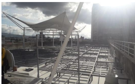
Figura 1, instalacion de estructura metálica para piso.
