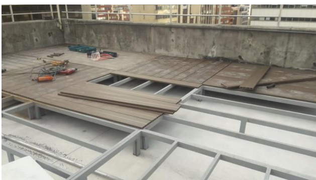
Figura 4, colocación de piso Deck
