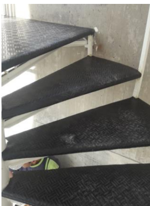
Figura 3, colocación de banda de caucho para escalera
