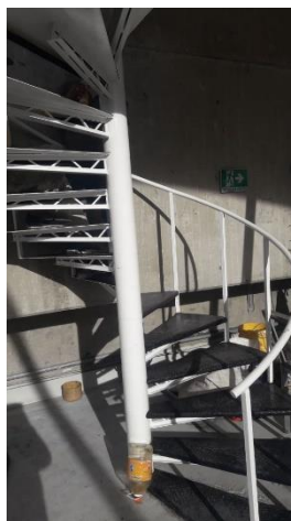
Figura 3, colocación de banda de caucho para escalera
