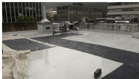
Figura 8, colocación de piso de caucho o llanta de 1 cm de espesor y 1,5m de ancho para sendero de mantenimiento para cubierta alta.
