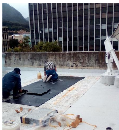
Figura 8, colocación de piso de caucho o llanta de 1 cm de espesor y 1,5m de ancho para sendero de mantenimiento para cubierta alta.
