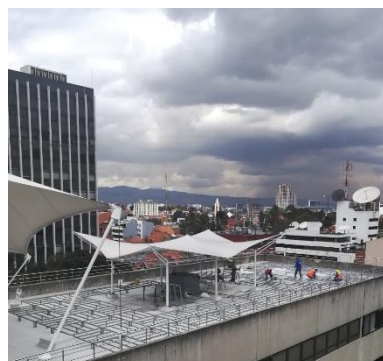
Figura 9, colocación de estructura metálica para soporte de piso
