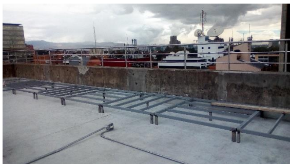
Figura 9, colocación de estructura metálica para soporte de piso
