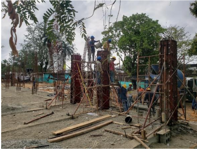
VACIADO DE COLUMNAS
