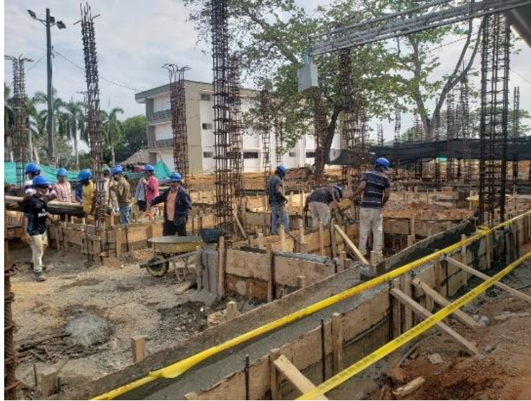
VACIADO VIGAS DE FUNDACIÓN
