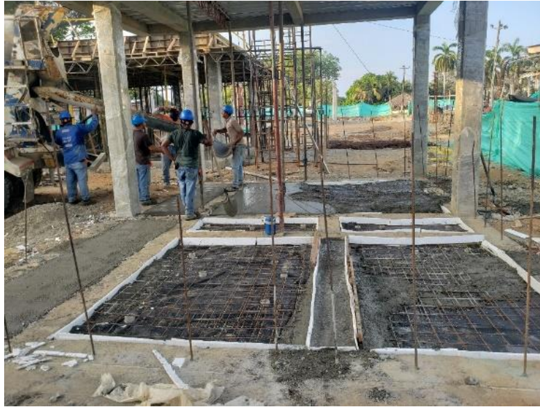
VACIADO DE LOSA DE CONTRAPISO
