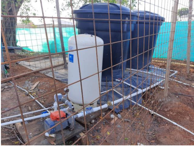
FOTO No 13 ,adecuación de tanques para abastecimiento de agua
