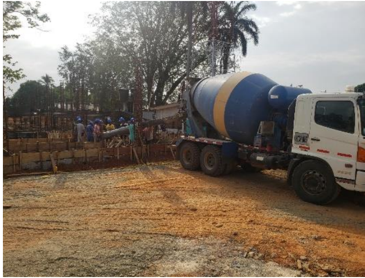
VACIADO VIGAS DE FUNDACIÓN
