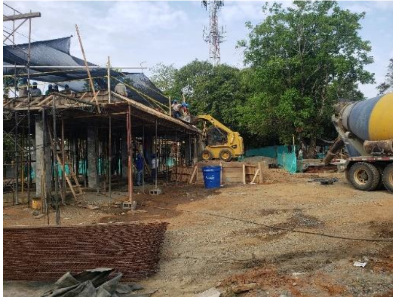
VACIADO LOSA DE CUBIERTA
