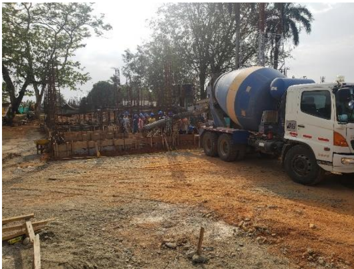
VACIADO VIGAS DE FUNDACIÓN
