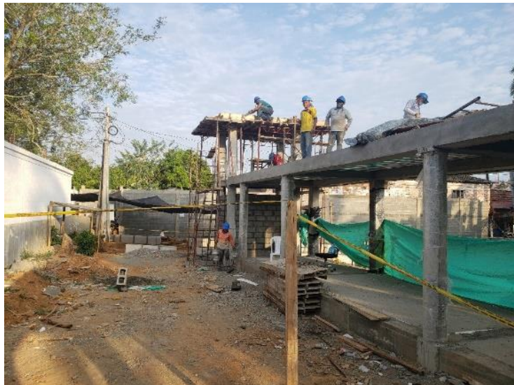
VACIADO LOSA DE CUBIERTA
