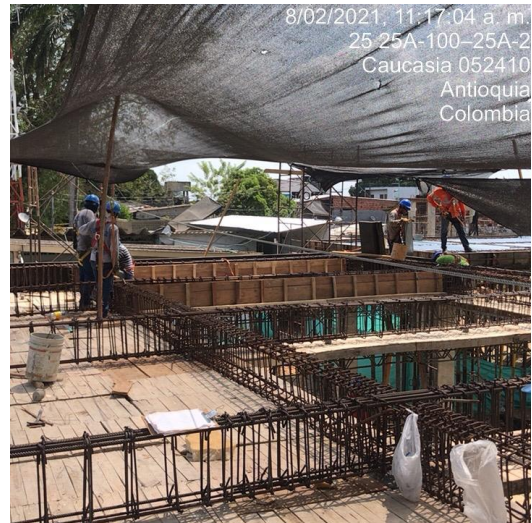
Foto No 6. Trabajo seguro de altura 08/02/21
