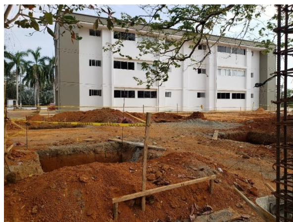
EXCAVACIÓN MANUAL PARA ZAPATAS
