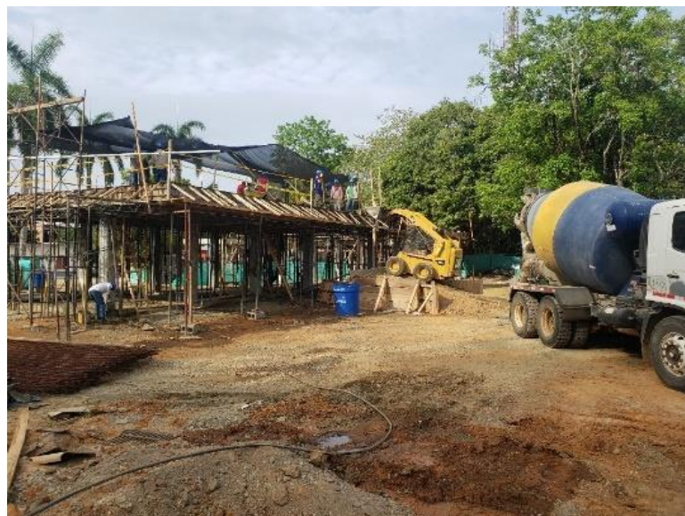
VACIADO LOSA DE CUBIERTA
