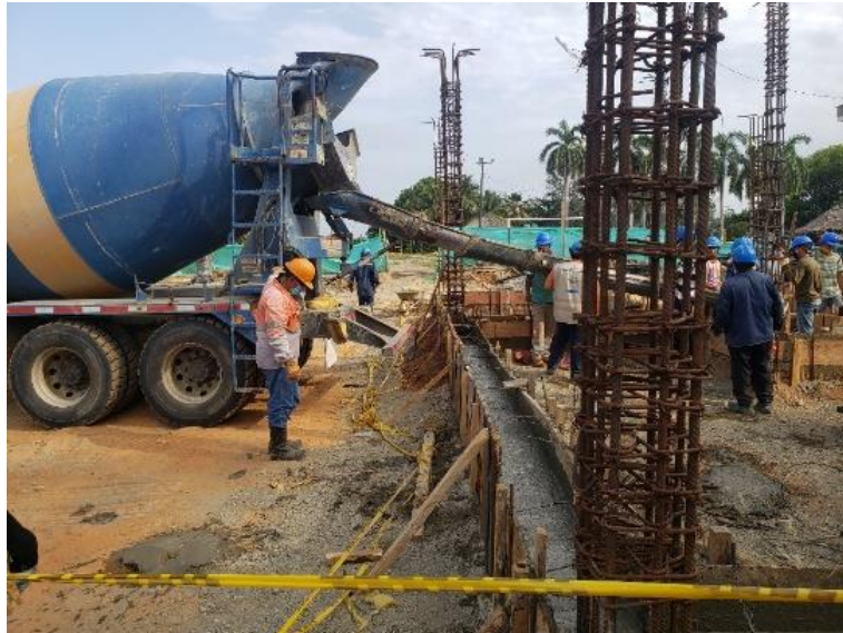
VACIADO VIGAS DE FUNDACIÓN
