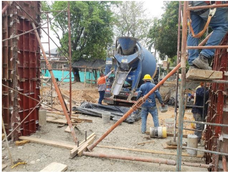
VACIADO DE COLUMNAS
