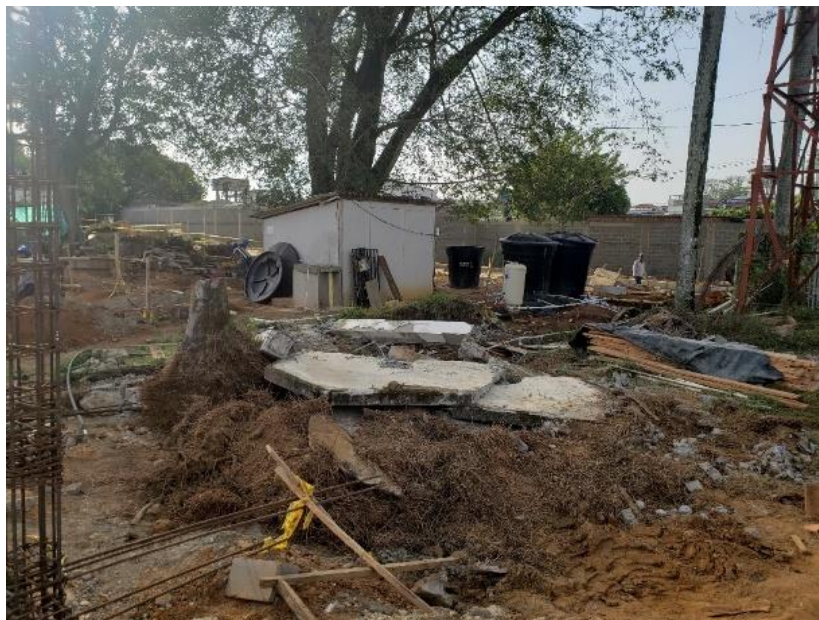
DEMOLICIÓN ESTRUCTURA DE TANQUES EXISTENTES
