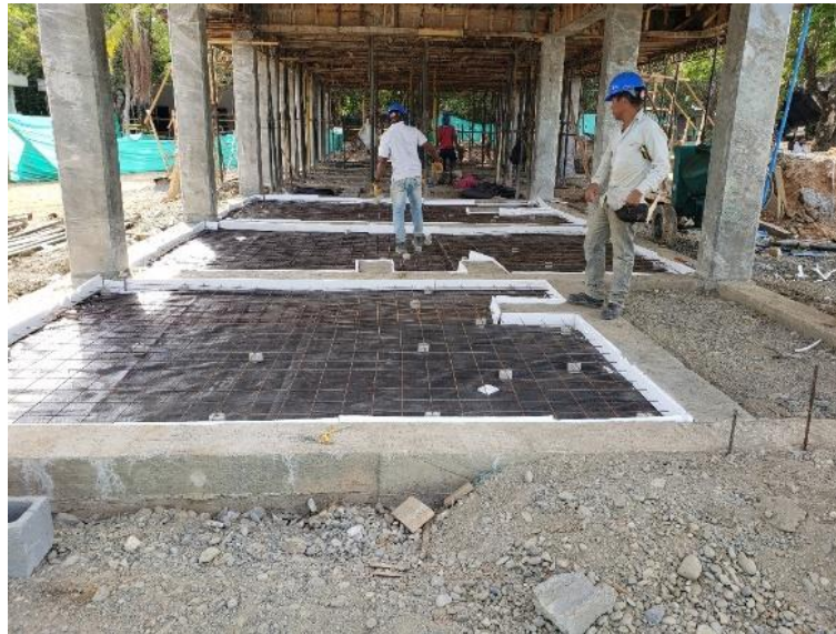
VACIADO LOSA DE CONTRAPISO
