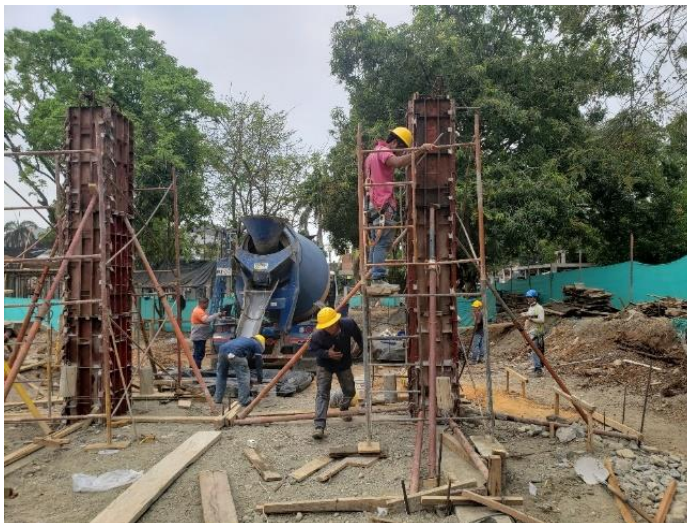
VACIADO DE COLUMNAS
