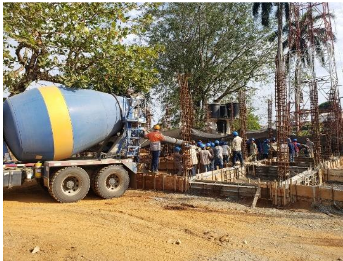
VACIADO VIGAS DE FUNDACIÓN
