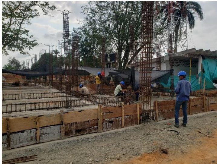
FORMALETEADA VIGAS DE FUNDACIÓN
