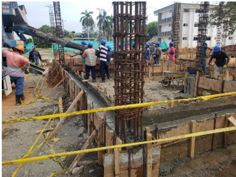
VACIADO VIGAS DE FUNDACIÓN
