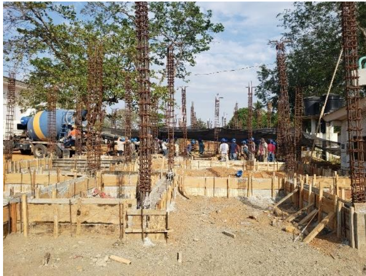
VACIADO VIGAS DE FUNDACIÓN
