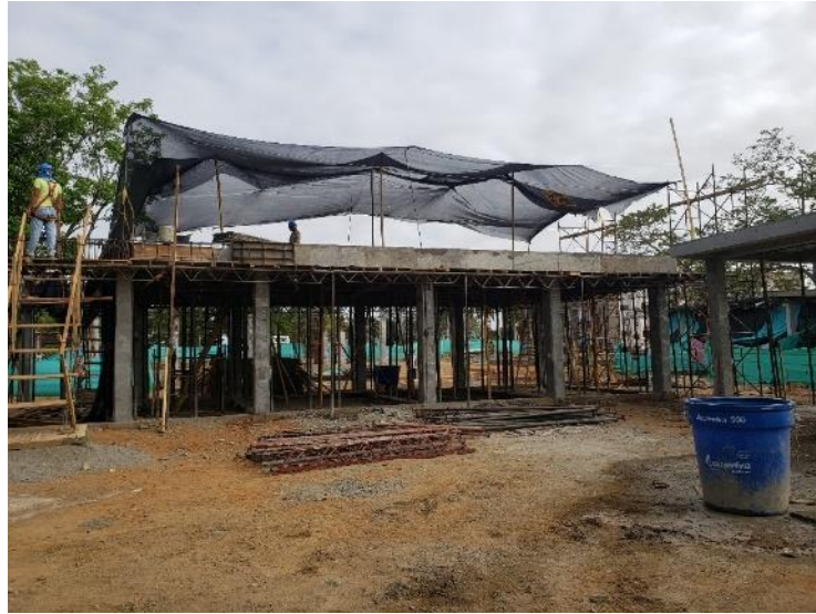
VACIADO LOSA DE CUBIERTA
