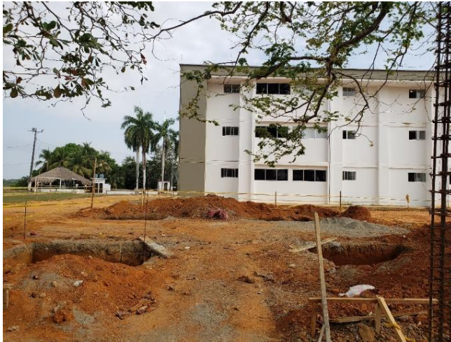
EXCAVACIÓN MANUAL PARA ZAPATAS
