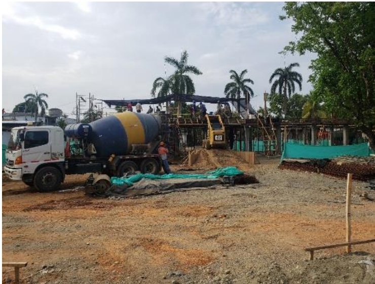
VACIADO LOSA DE CUBIERTA
