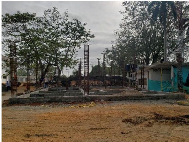
VACIADO VIGAS DE FUNDACIÓN
