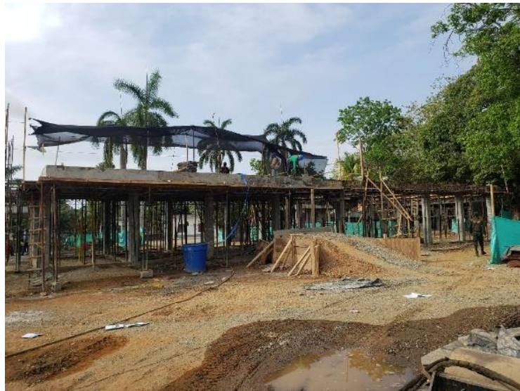
VACIADO LOSA DE CUBIERTA
