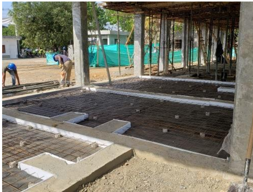
VACIADO LOSA DE CONTRAPISO
