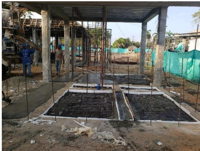
VACIADO LOSA DE CONTRAPISO
