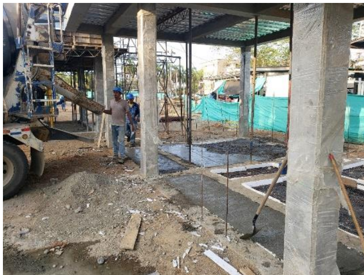
VACIADO LOSA DE CONTRAPISO
