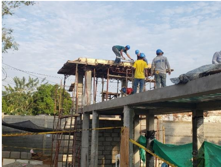
VACIADO LOSA DE CUBIERTA
