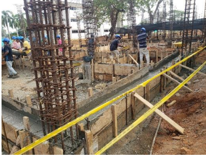
VACIADO VIGAS DE FUNDACIÓN
