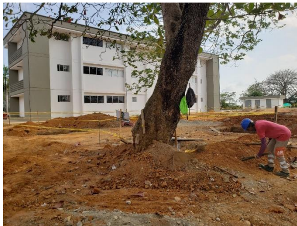
EXCAVACIÓN MANUAL PARA ZAPATA
