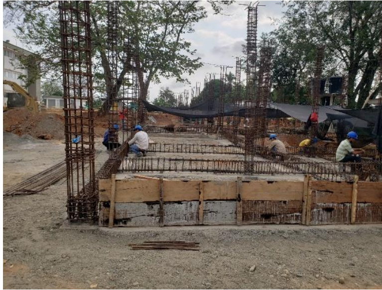
FORMALETEADA VIGAS DE FUNDACIÓN
