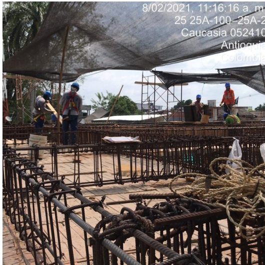
Foto No 5. Trabajo seguro en altura 08/02/21
