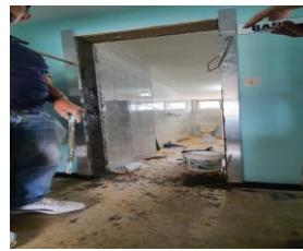
DESCRIPCION BANO EN ADECUACION
