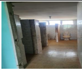
DESCRIPCION: BANO EN ADECUACION
