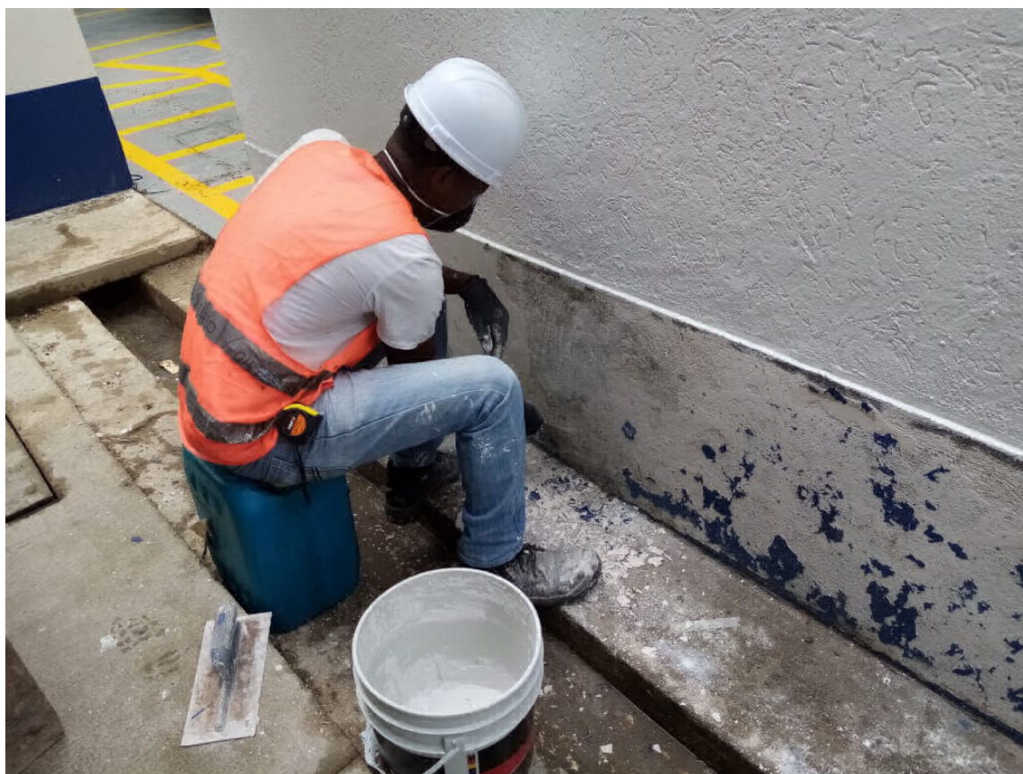
ESTUCO Y PINTURA M2 DE AEROPUERTO GERARDO TOVAR LOPEZ DE BUENAVENTURA, VALLE DEL CAUCA.
