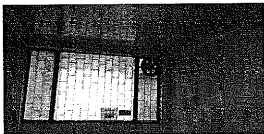
ILUMINACIÓN Y VENTILACIÓN
