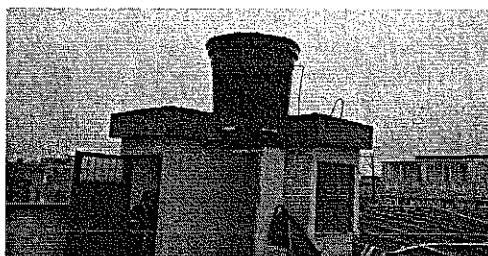
TANQUE DE AGUA
