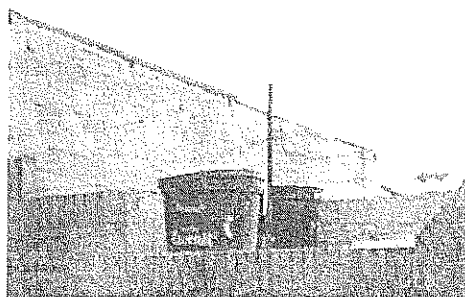
TANQUE DE AGUA
