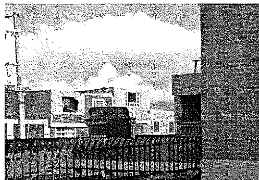
TANQUE DE AGUA
