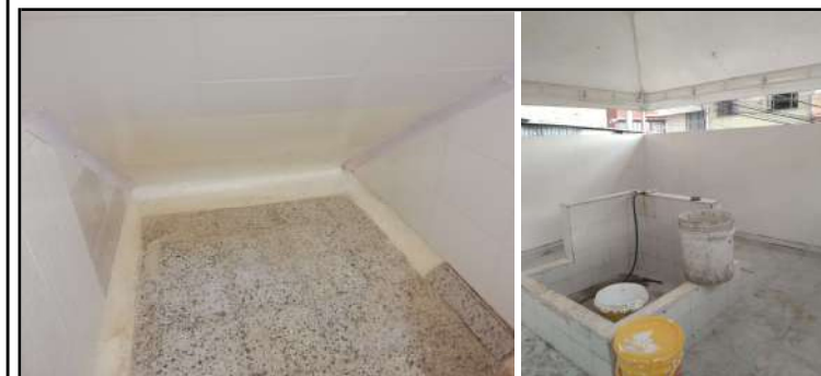
DESCRIPCION: CUARTO DE ASEO Y ZONA DE LAVADO DE UTENSILIOS
