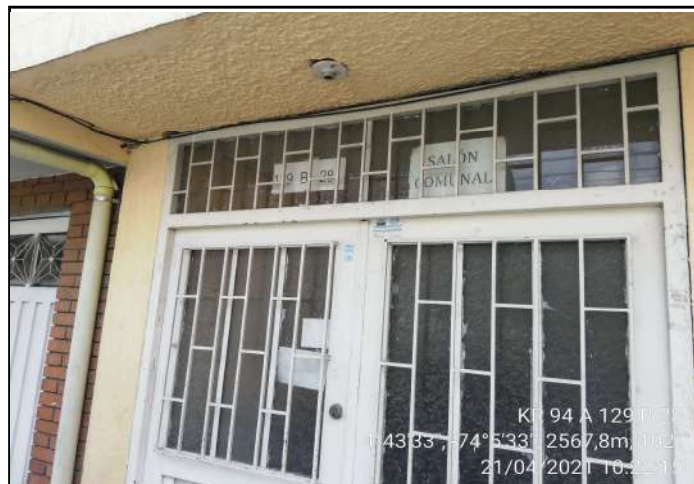
DESCRIPCIÓN: FACHADA. Visita deVerificación de subsanaciones de requisitos habilitantes el día 21/04/2021. El oferente no gestiona el ingreso al inmueble
