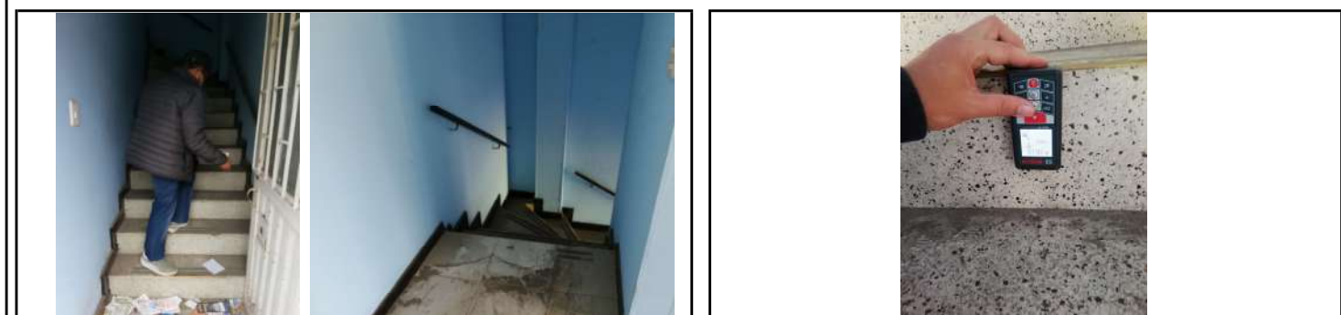
DESCRIPCION: CIELORRASO DE DESPENSA 1 DESCRIPCION: ESCALERAS
