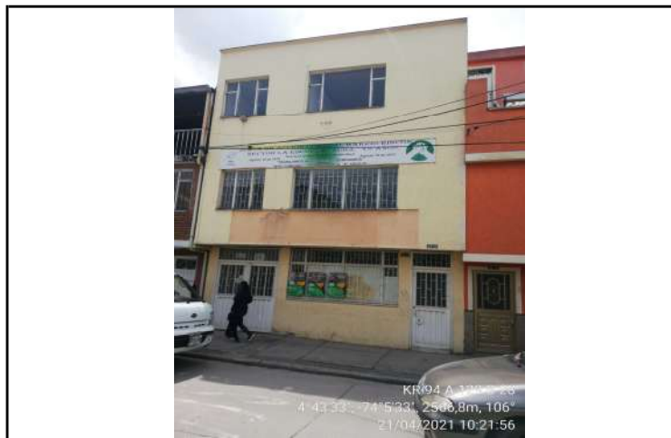
DESCRIPCIÓN: FACHADA. Visita deVerificación de subsanaciones de requisitos habilitantes el día 21/04/2021. El oferente no gestiona el ingreso al inmueble
