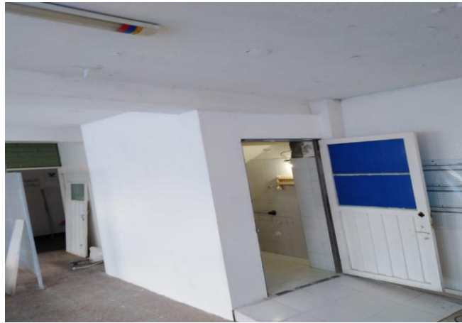
2. Ampliación baño usuarios (puerta. Pared y rampa)
