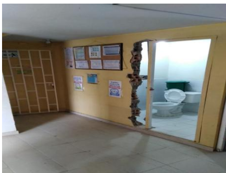
4. Ampliación acceso a baño de Funcionarios.
