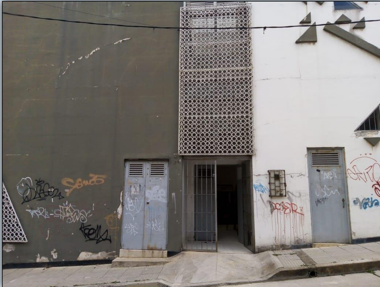
Rampa de acceso movilidad reducida
