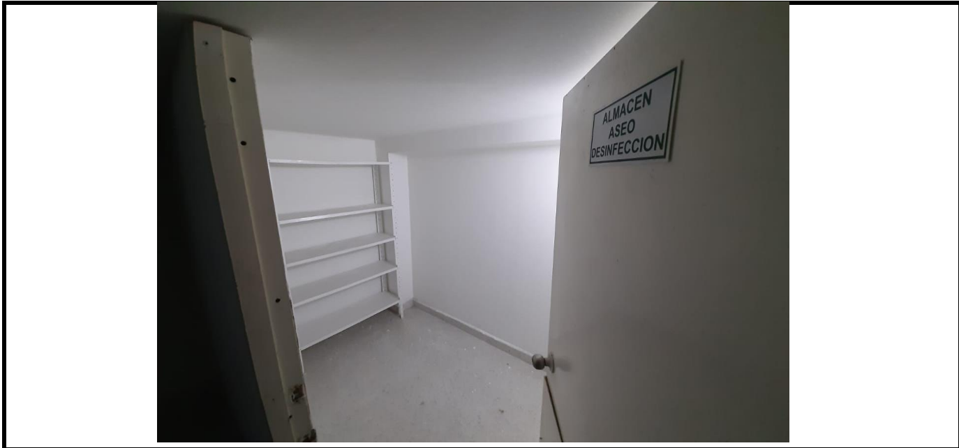
SEGUNDA VISITA - ADECUACION CUARTO DE ASEO
