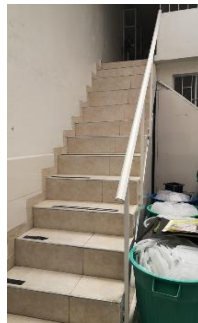
DESCRIPCIÓN: AREA ADICIONAL A COCINA
