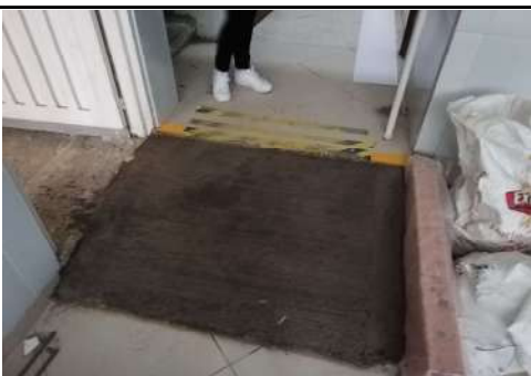
DESCRIPCION: SEGUNDA VISITA. RAMPA DE ACCESIBILIDAD (SUBSANADO)
