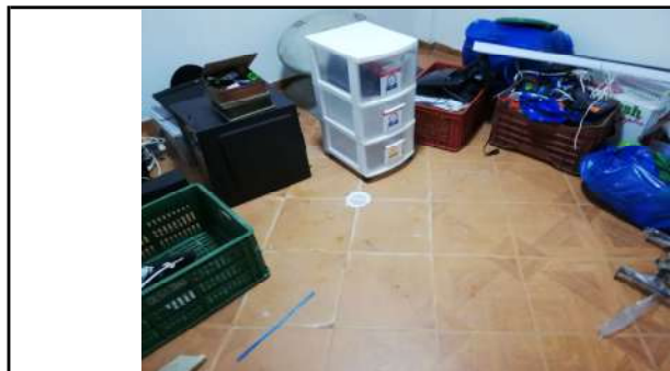
DESCRIPCION: ACADADO DE PISO Y DESAGUE. DESPENSA
